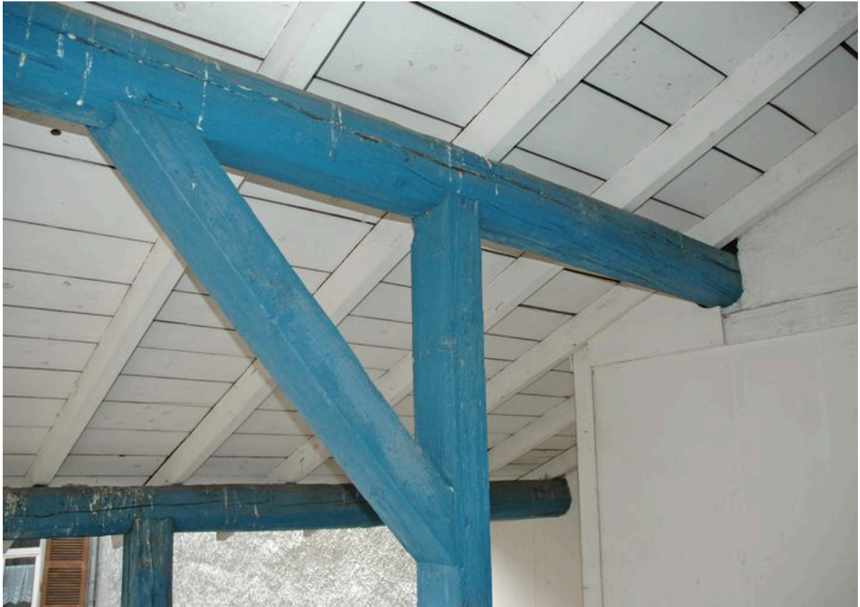
Détails de la toiture couvrant la cage d'escalier : poinçon et contrefiche soutenant une panne
