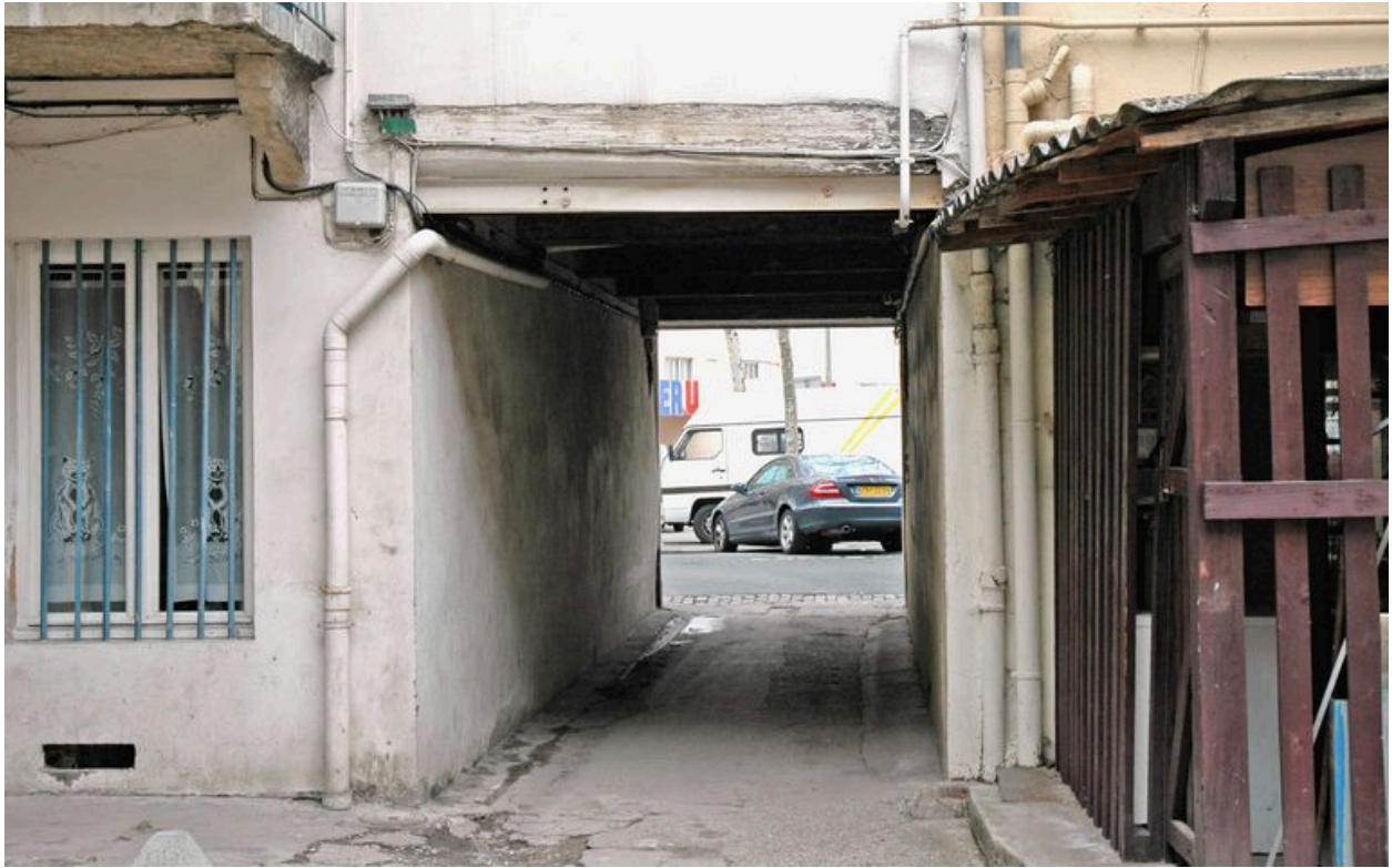
Vue du passage couvert depuis la cour
