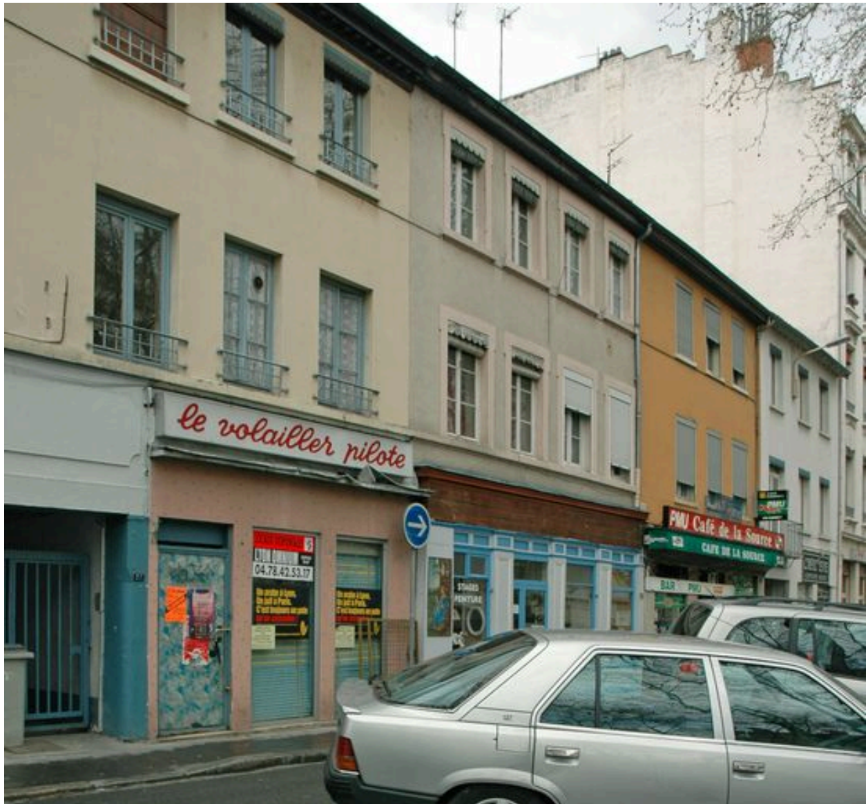
Façade sur la rue Claude Boyer vue depuis le nord-est
