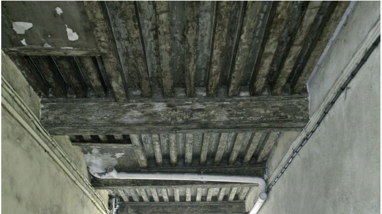
Détail de plafond charpenté du passage couvert
