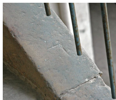
Marque de tâcheron sur la face supérieure du limon extérieur Phot. Maryannick Chalabi IVR82_20066901355NUCA
