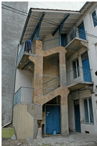
Cage d'escalier vue depuis le nord Phot. Maryannick Chalabi IVR82_20066901360NUCA
