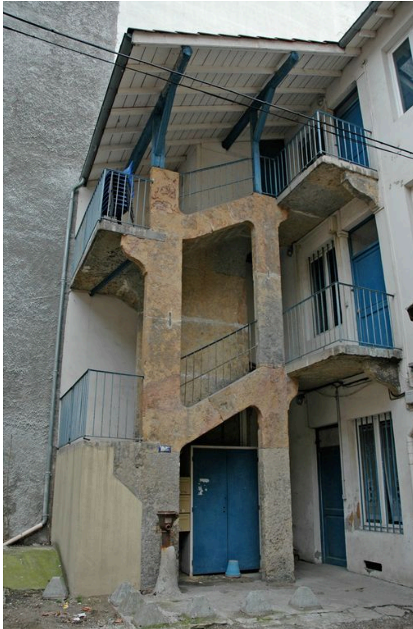
Cage d'escalier vue depuis le nord
