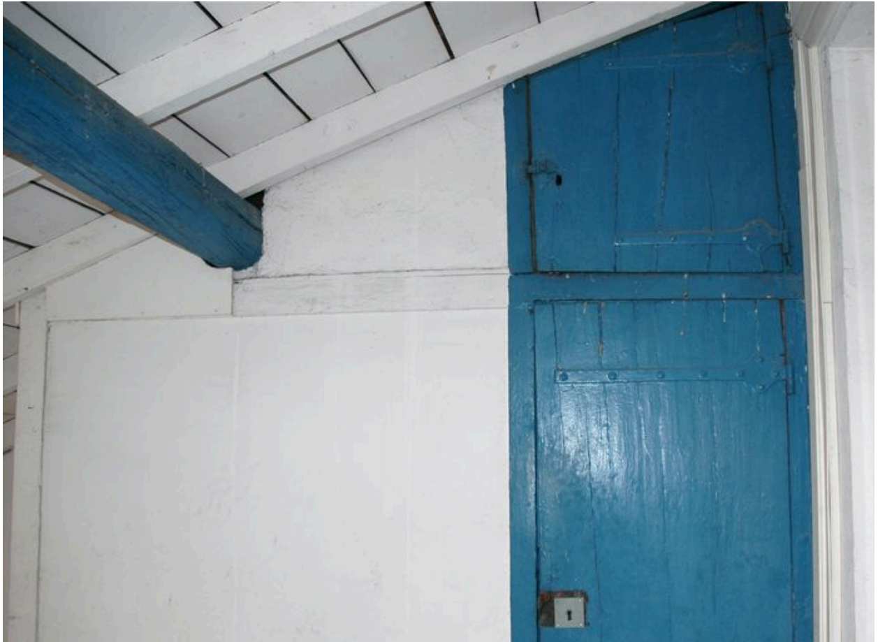
Placard aménagé au sud du dernier palier
