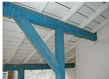
Détails de la toiture couvrant la cage d'escalier : poinçon et contrefiche soutenant une panne Phot. Maryannick Chalabi IVR82_20066901358NUCA
