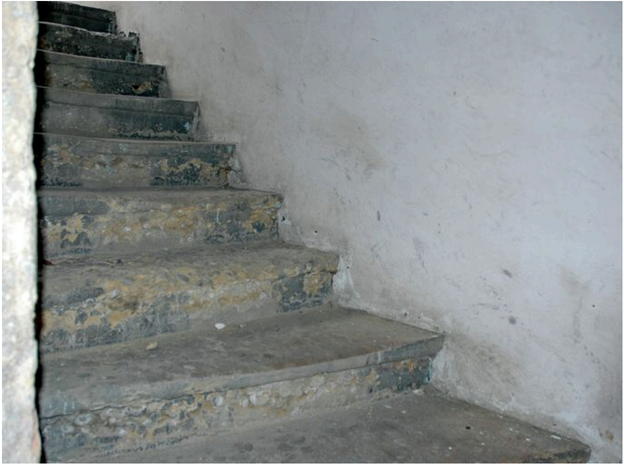
Détail de la volée d'escalier sud
