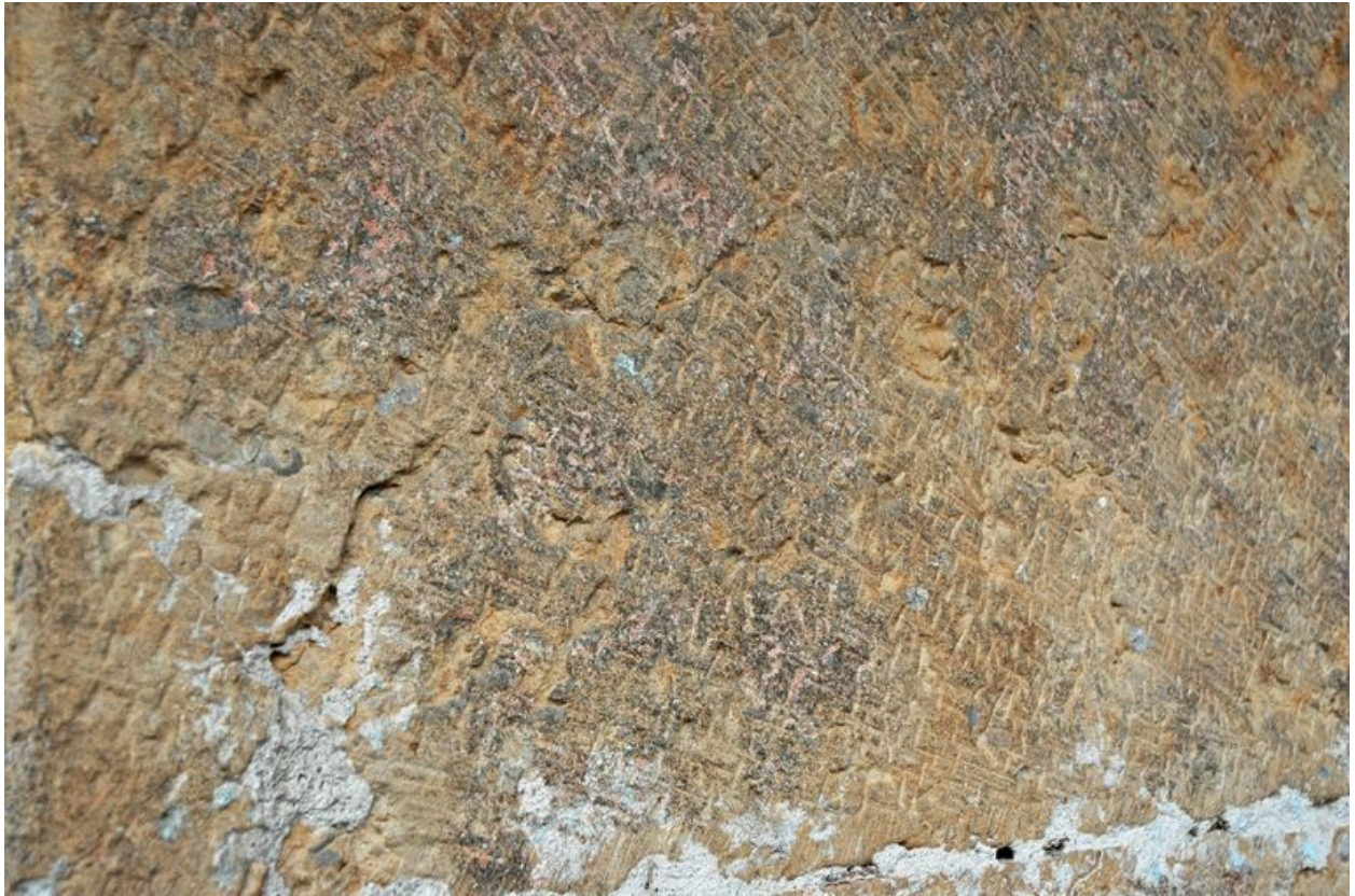
Marques d'outils sur les pierres constituant la cage d'escalier
