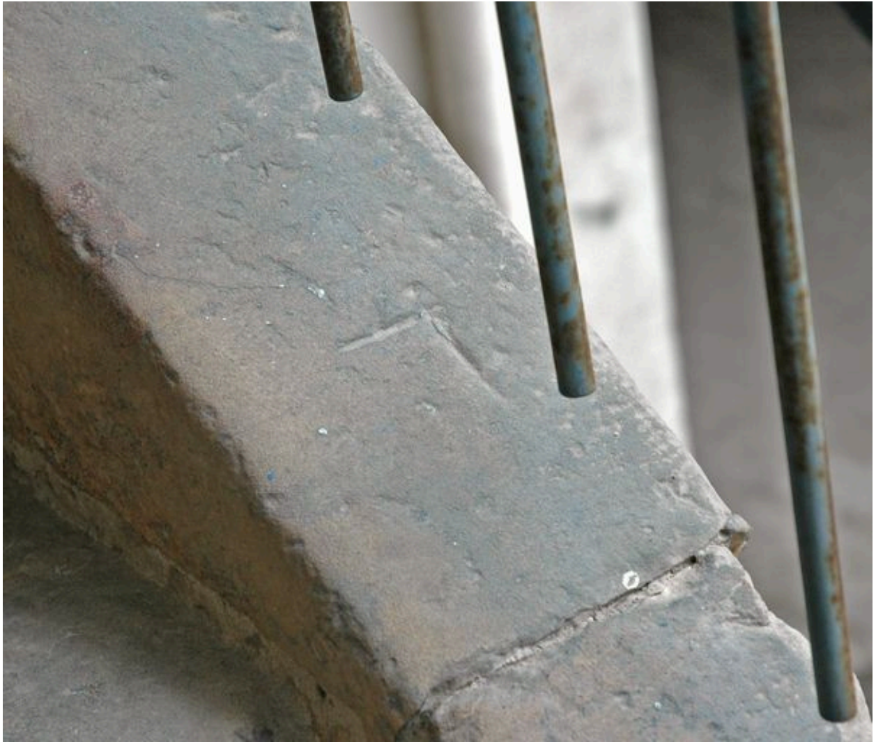
Marque de tâcheron sur la face supérieur du limon extérieur
