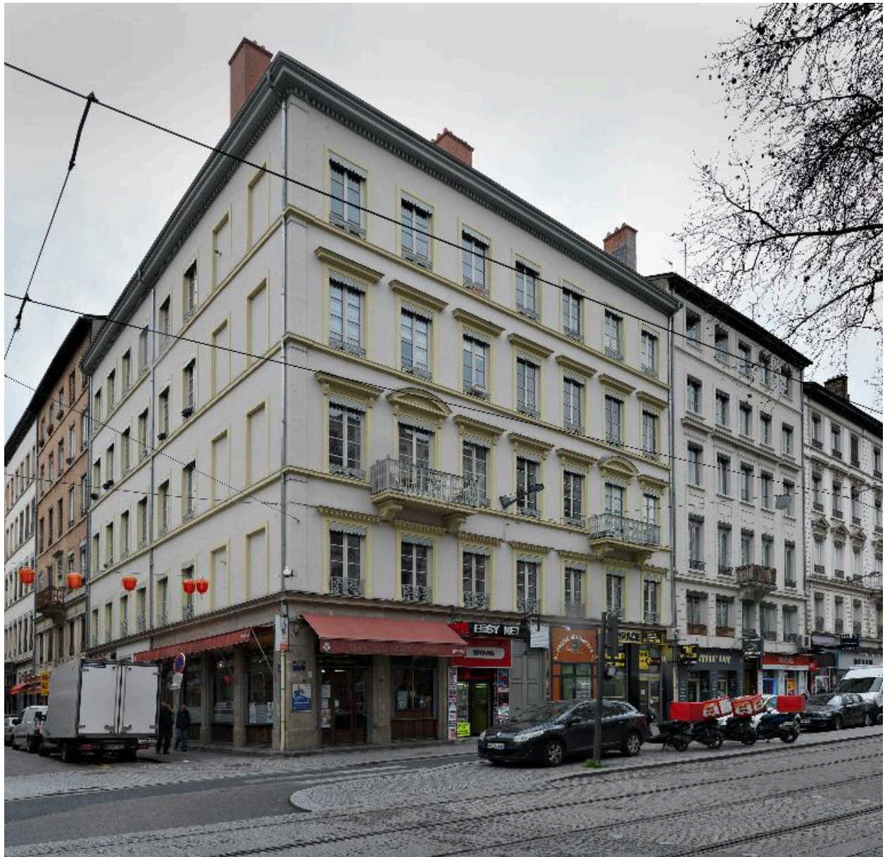
Vue de situation au sein de l'ilot (à droite)
