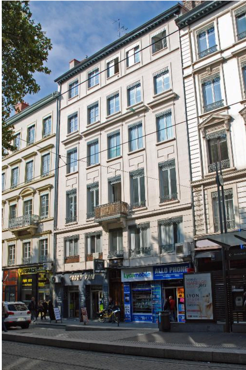
Vue d'ensemble de l'élévation sur rue
