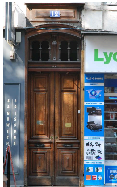
Elévation sur rue : porte bâtarde, imposte à balustres Phot. Magali Delavenne IVR82_20156901182NUCA
