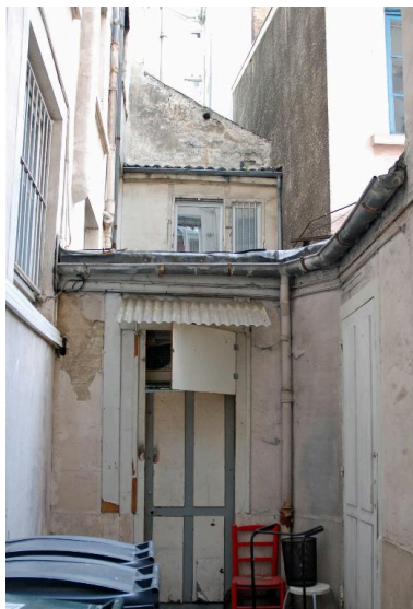
Vue de la loge de concierge, depuis la cour du 13 place Gabriel-Péri Phot. Magali Delavenne IVR82_20156901187NUCA
