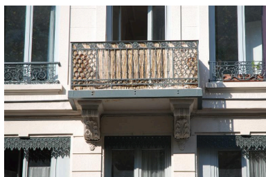
Elévation sur rue : balcon, ferronneries identiques à celle du 13 place Gabriel-Péri Phot. Magali Delavenne IVR82_20156901183NUCA
