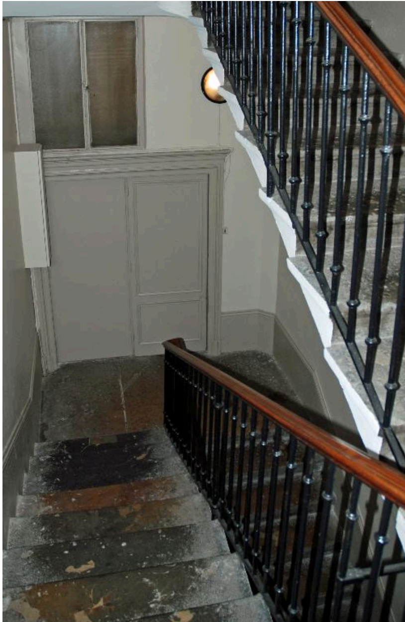
Vue intérieure : le premier repos de l'escalier et la porte de la loge de concierge
