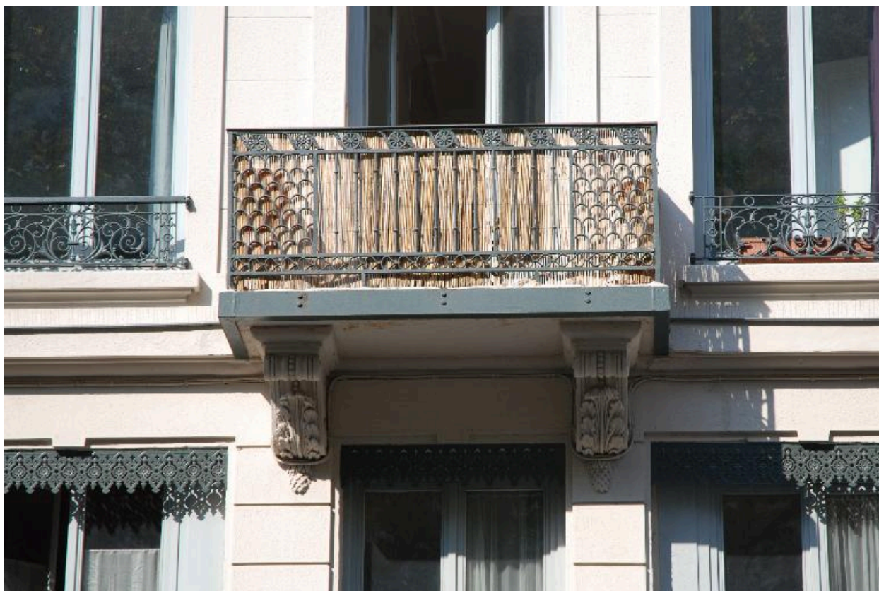
Elévation sur rue : balcon, ferronneries identiques à celle du 13 place Gabriel-Péri
