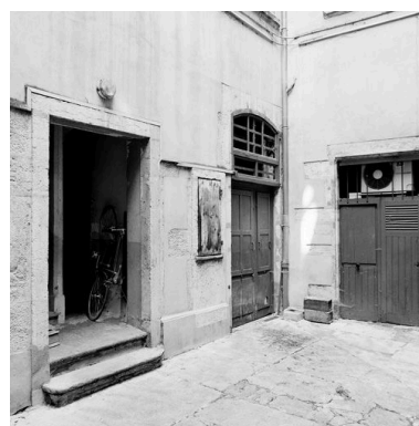
Angle du bâtiment en fond de cour (à gauche) avec l'aile droite. Entrée du 2e escalier et puits Phot. Didier Gourbin IVR82_20056902503X
