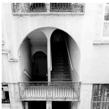
Cour, 1er bâtiment, rez- de-chaussée de l'escalier Phot. Didier Gourbin IVR82_20056902502X
