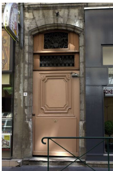
Façade sur rue, porte Phot. Bernard Ducouret IVR82_20036901325NUCA
