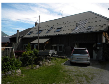
Façade principale d'une ancienne ferme (2008 C8 1160). Phot. Jérôme Daviet IVR82_20117403717NUCA
