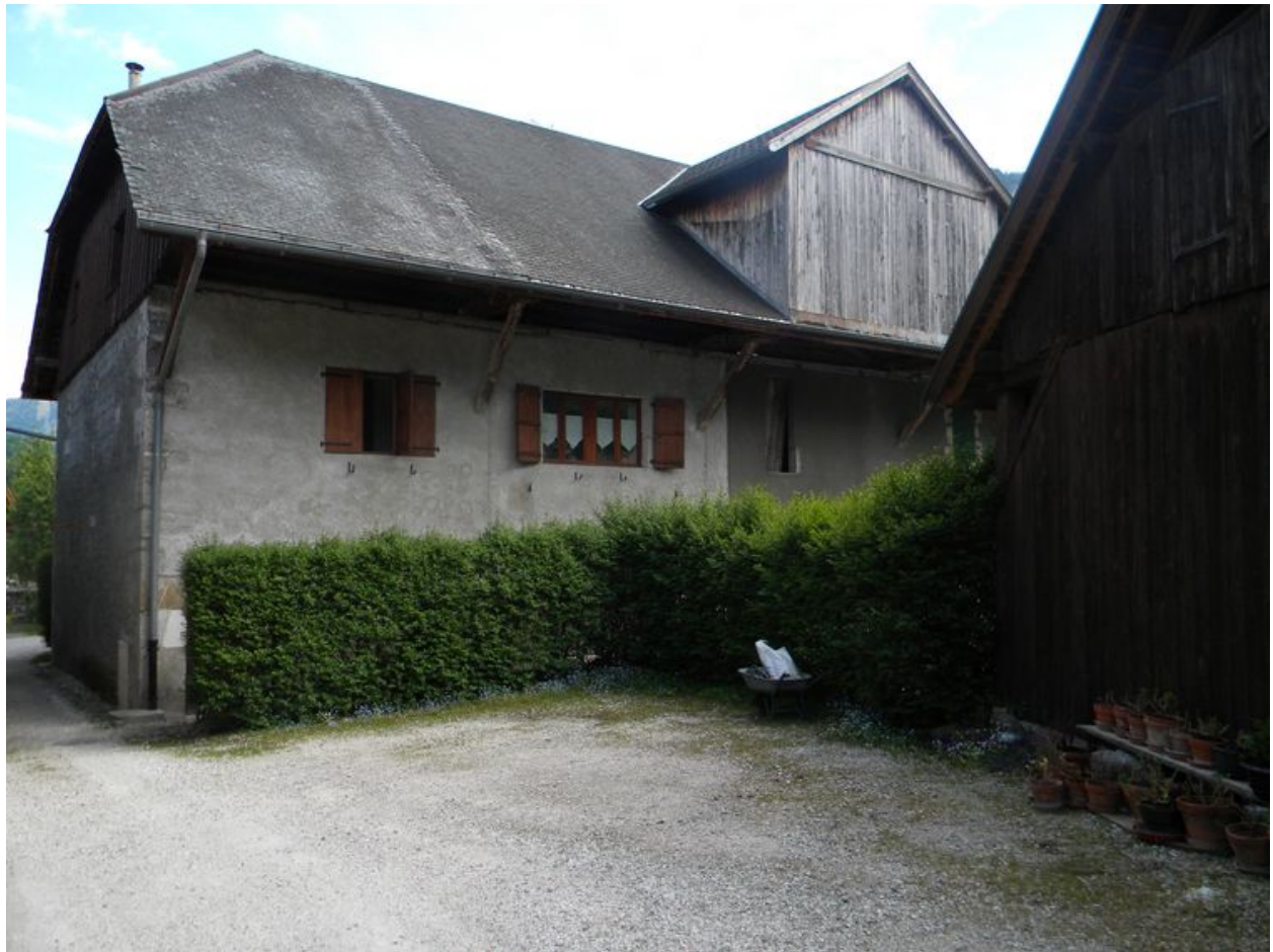
façade arrière d'une ancienne ferme avec lucarne dans le toit pour le passage d'un monte foin (2008 C8 2624, 2625, 2853).
