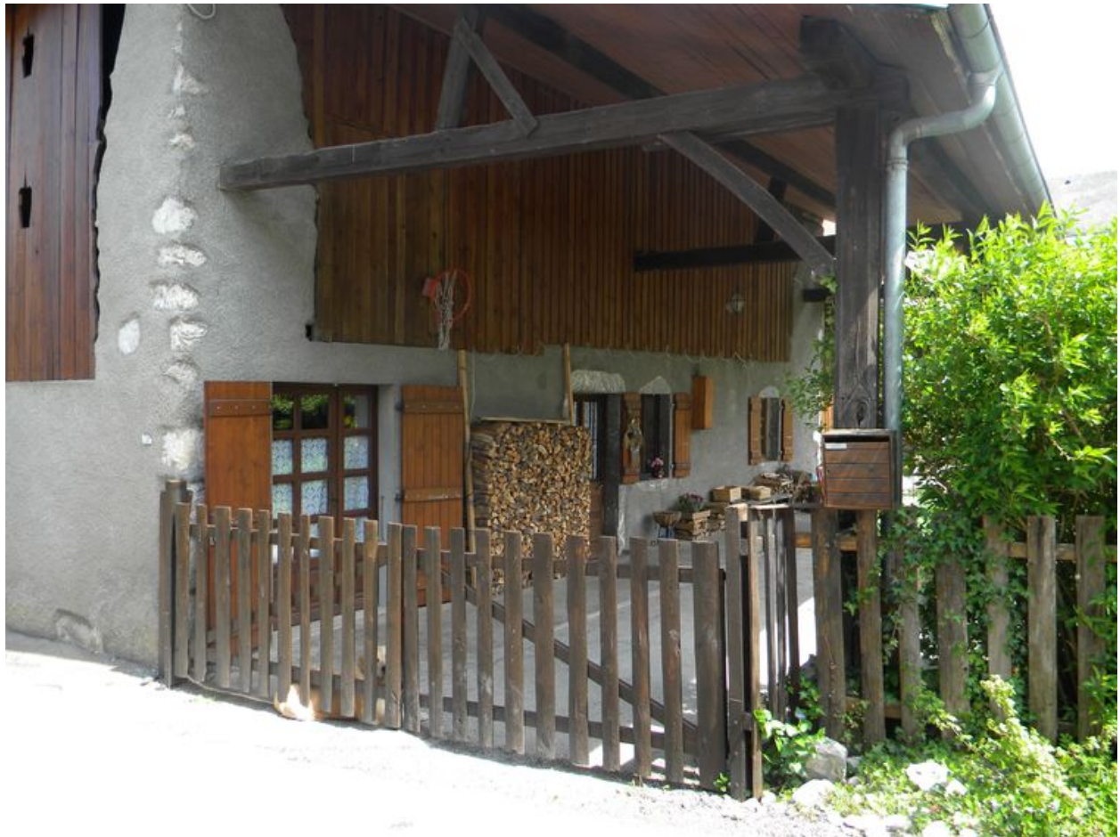
Façade principale d'une ferme (2008 C8 1138)
