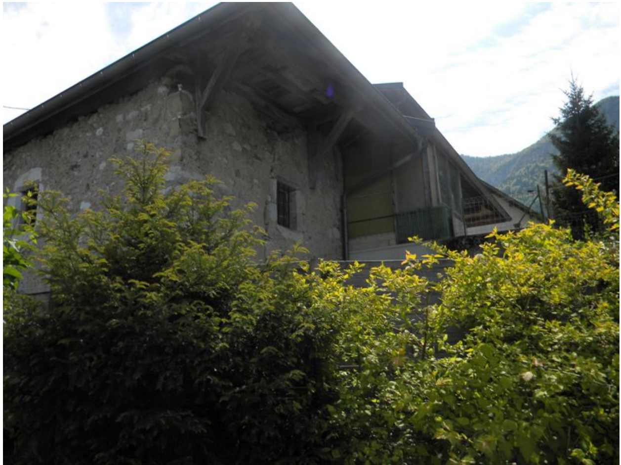
Façade nord d'une ancienne maison très transformée (2008 C8 1175).
