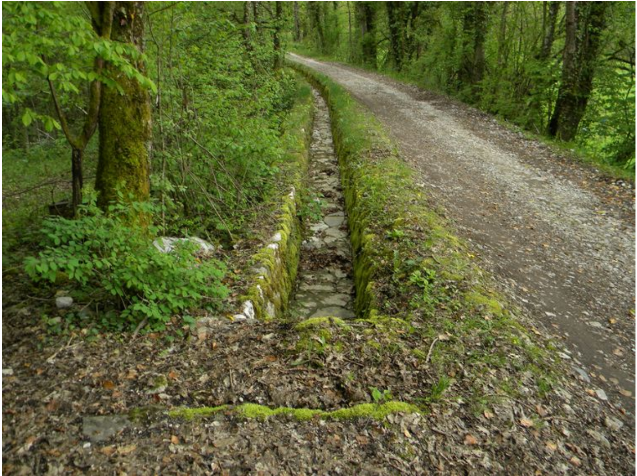
Vue du chenal d'écoulement d'eau le long du chemin de Marceau à Saury
