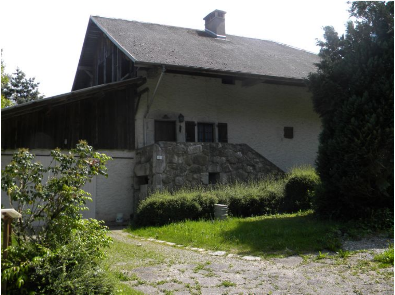
Escalier en pier rajouté sur la façade ouest d'une ancienne ferme (2008 C8 2123).
