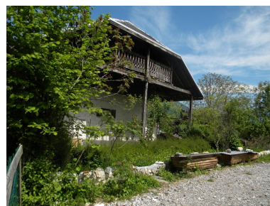
Avancée de toiture sous demi- croupe avec espace de séchage d'une ancienne ferme (2008 C8 1213). Phot. Jérôme Daviet IVR82_20117403721NUCA
