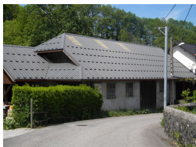
Façade sur rue d'une ancienne scierie le long de l'Ire (2008 C8 2755) Phot. Jérôme Daviet IVR82_20117403710NUCA
