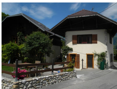
Façade nord d'une ancienne ferme (2008 C8 3272, 1916) Phot. Jérôme Daviet IVR82_20117403711NUCA
