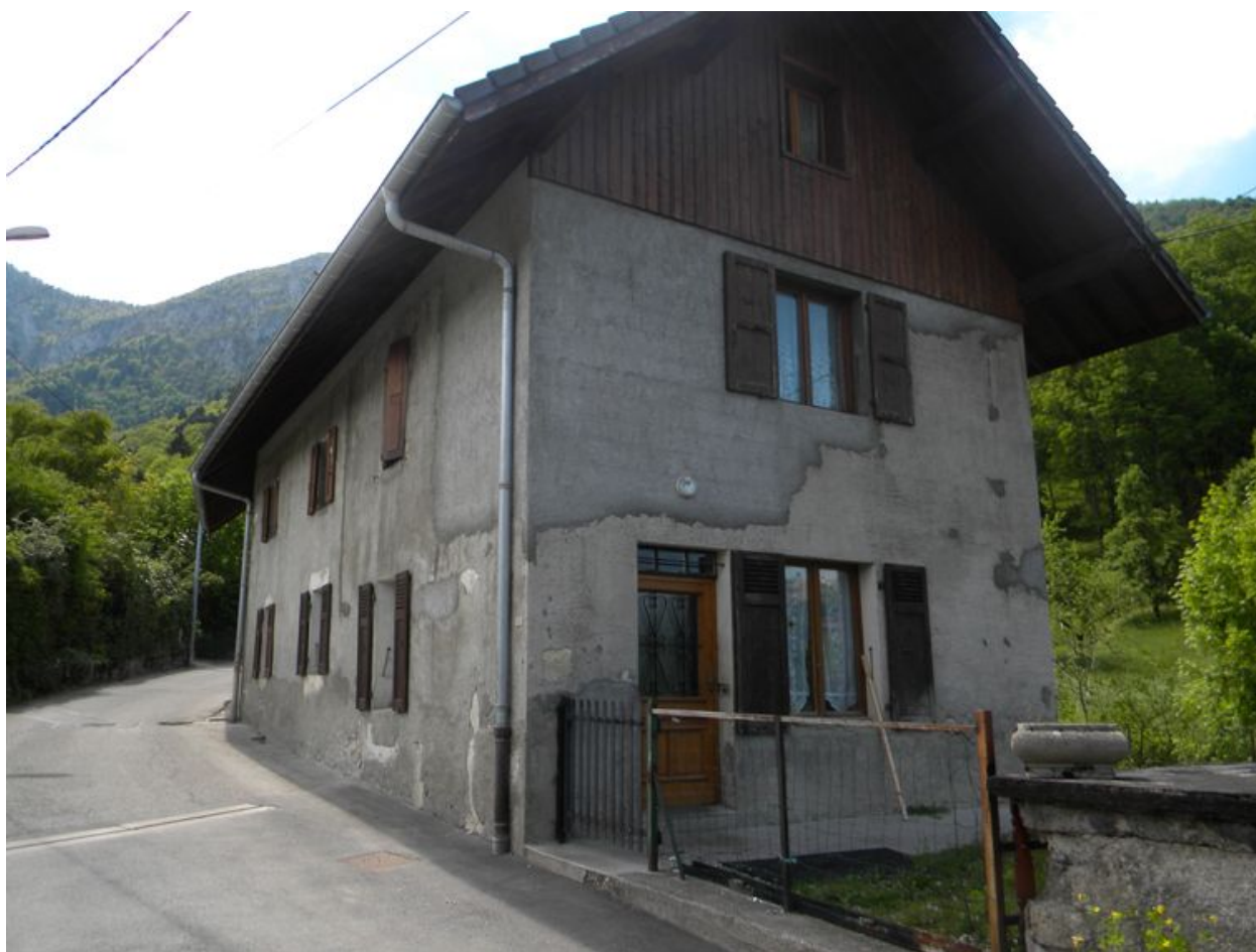
Vue de la façade nord d'une ancienne huilerie (2008 C8 2567).
