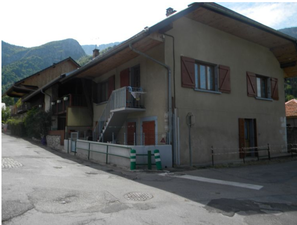
Vue d'ensemble d'une ancienne ferme à l'angle d'une rue (2008 C8 1247, 1248).
