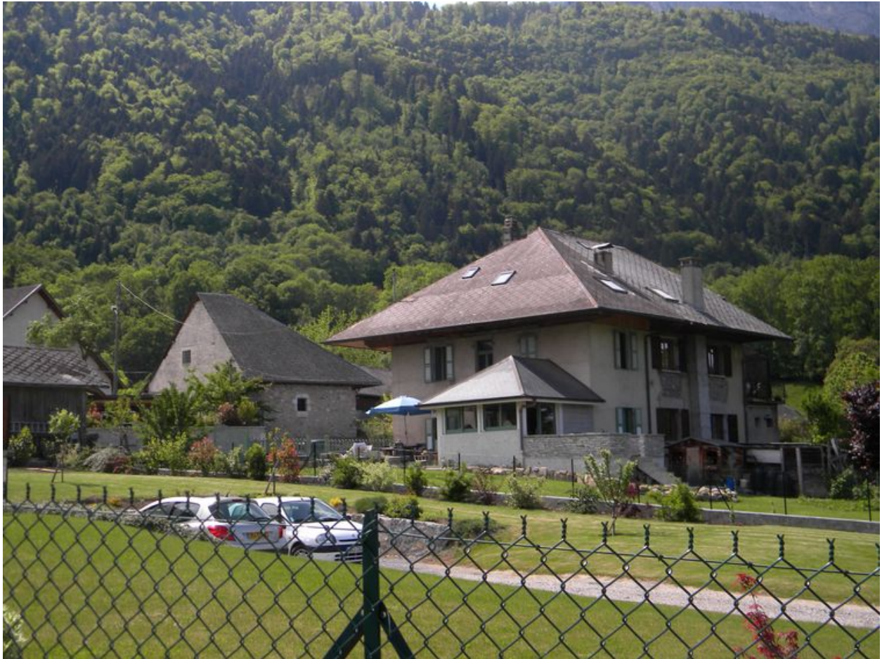
Vue d'ensemble d'une ferme du début du XXe siècle jouxtant une ancienne ferme transformée.
