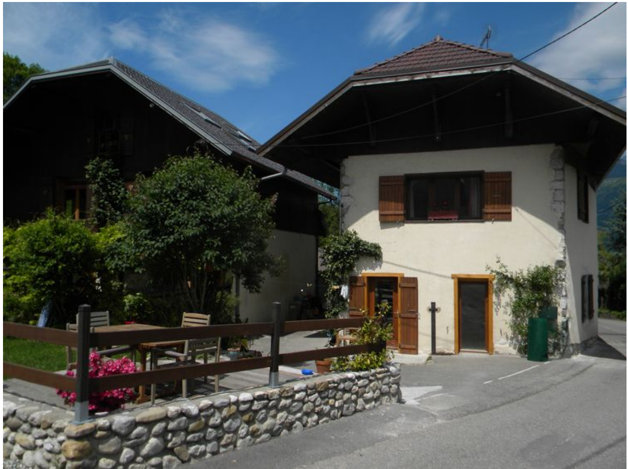
Façade nord d'une ancienne ferme (2008 C8 3272, 1916)
