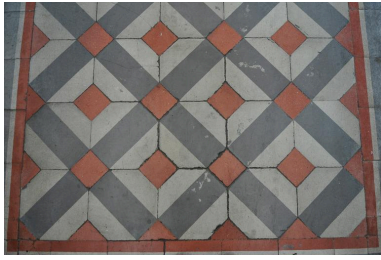
Vue intérieure, détail du pavement de l'allée Phot. Magali Delavenne IVR84_20176901504NUCA
