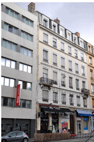
Vue générale, élévation sur rue Phot. Magali Delavenne IVR84_20176901473NUCA
