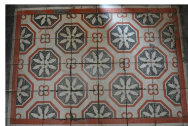
Vue intérieure, détail du pavement de l'allée Phot. Magali Delavenne IVR84_20176901503NUCA
