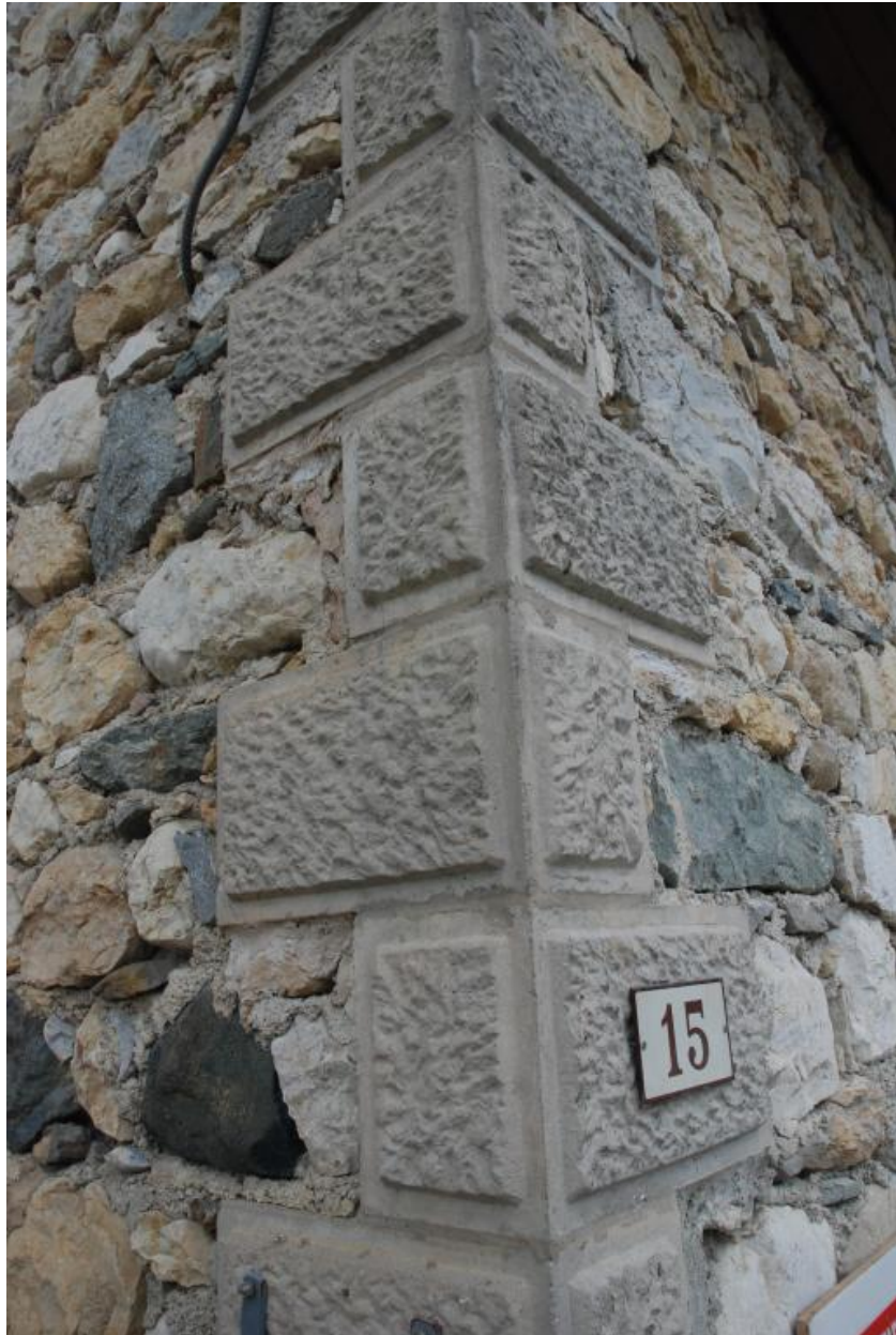
Détail d'une chaîne d'angle en béton moulé
