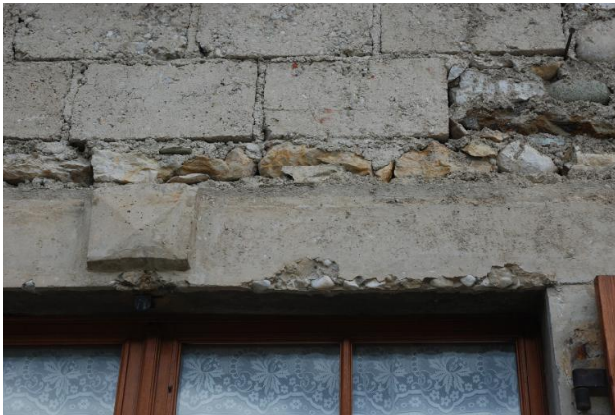
Détail d'un linteau en béton moulé du pignon sud
