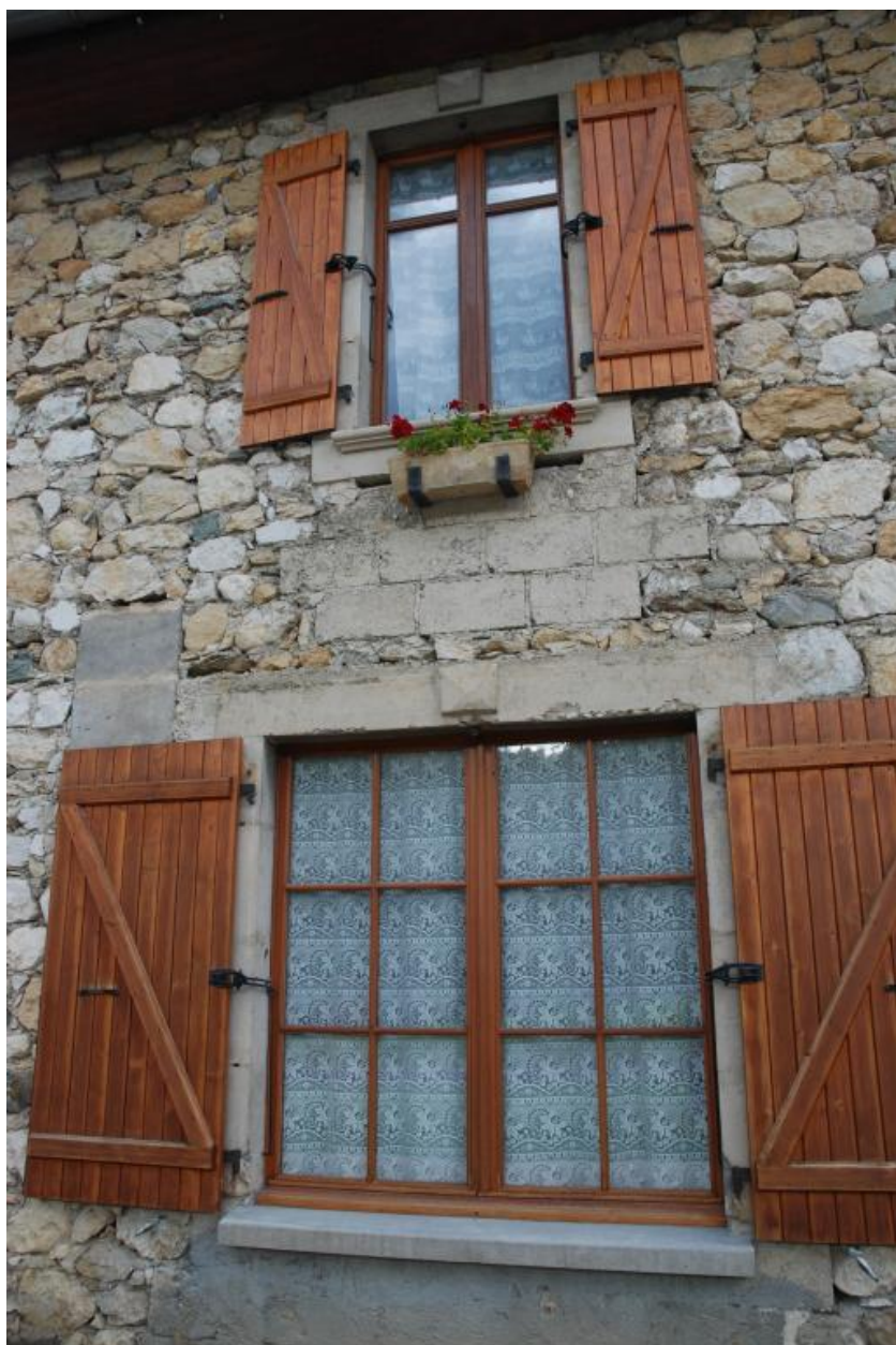
Détail de baies du mur pignon sud
