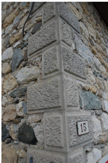
Détail d'une chaîne d'angle en béton moulé Phot. Thierry Monnet IVR84_20207400890NUCA
