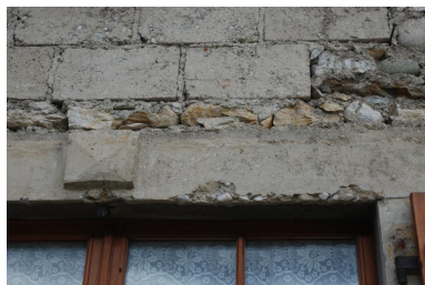
Détail d'un linteau en béton moulé du pignon sud Phot. Thierry Monnet IVR84_20207400889NUCA
