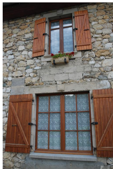
Détail de baies du mur pignon sud Phot. Thierry Monnet IVR84_20207400888NUCA
