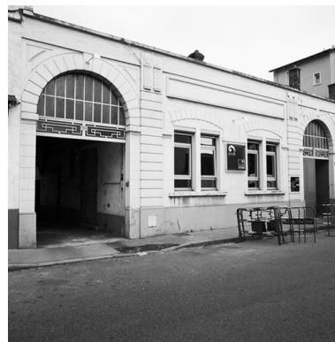
Détail façade Phot. Jean-Marie Refflé IVR82_20026904472X
