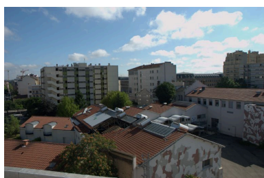
Elévation postérieure depuis l'ouest Phot. M Chalabi IVR82_20086900871NUCA
