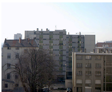
Vue générale depuis le nord Phot. Maryannick Chalabi IVR82_20126902456NUCA
