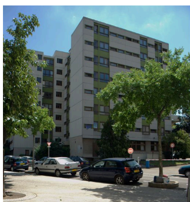
Vue d'ensemble depuis le nord-ouest Phot. Maryannick Chalabi IVR82_20086900879NUCA
