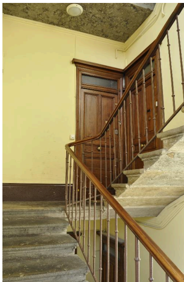
Vue intérieure de l'immeuble : un palier de l'escalier Phot. Magali Delavenne IVR82_20156902544NUCA
