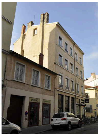
Vue d'ensemble depuis l'ouest : la maison sur la rue d'Aguesseau et le pignon de l'immeuble d'angle Phot. Magali Delavenne IVR82_20156902578NUCA
