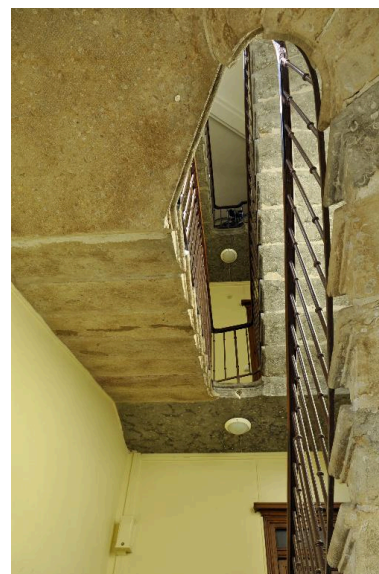
Vue intérieure de l'immeuble : l'escalier Phot. Magali Delavenne IVR82_20156902543NUCA
