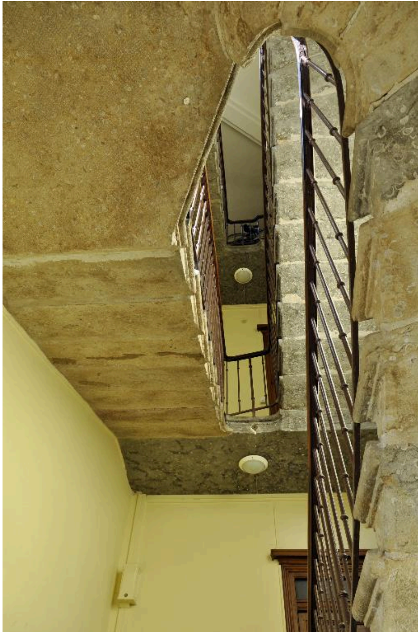
Vue intérieure de l'immeuble : l'escalier
