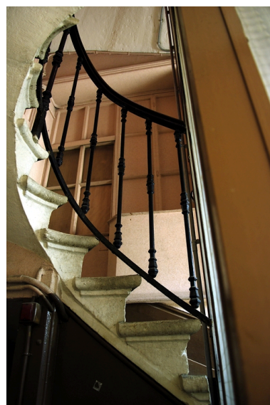
Porte de l'ancienne loge de concierge ouvrant sur la première volée d'escalier ? Phot. Véronique Belle IVR82_20096904839NUCA
