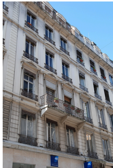
Elévation rue des Archers : les étages carrés Phot. Véronique Belle IVR82_20096904837NUCA
