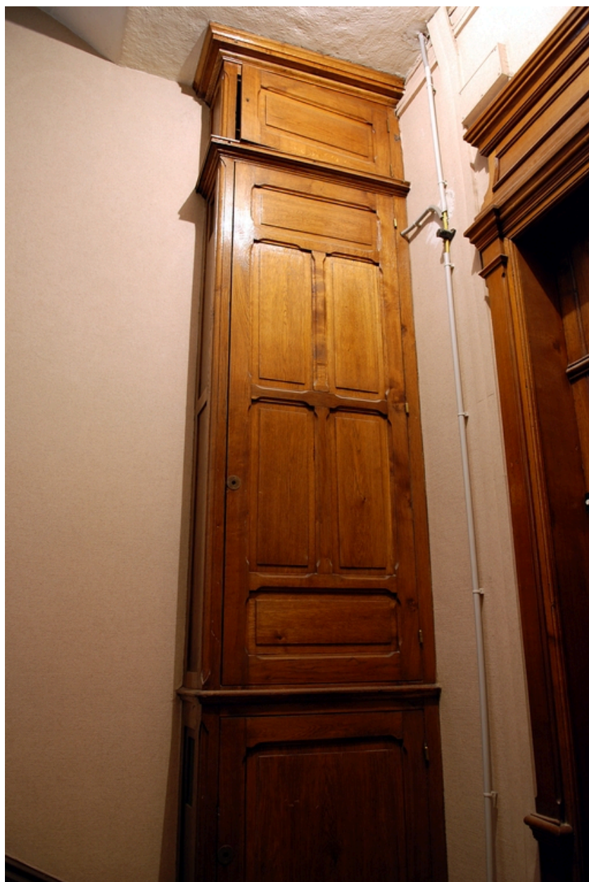
Placard aménagé sur un palier
