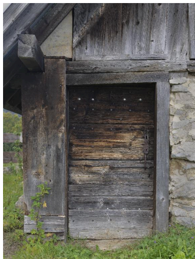
Détail de la porte du bâtiment nord.
