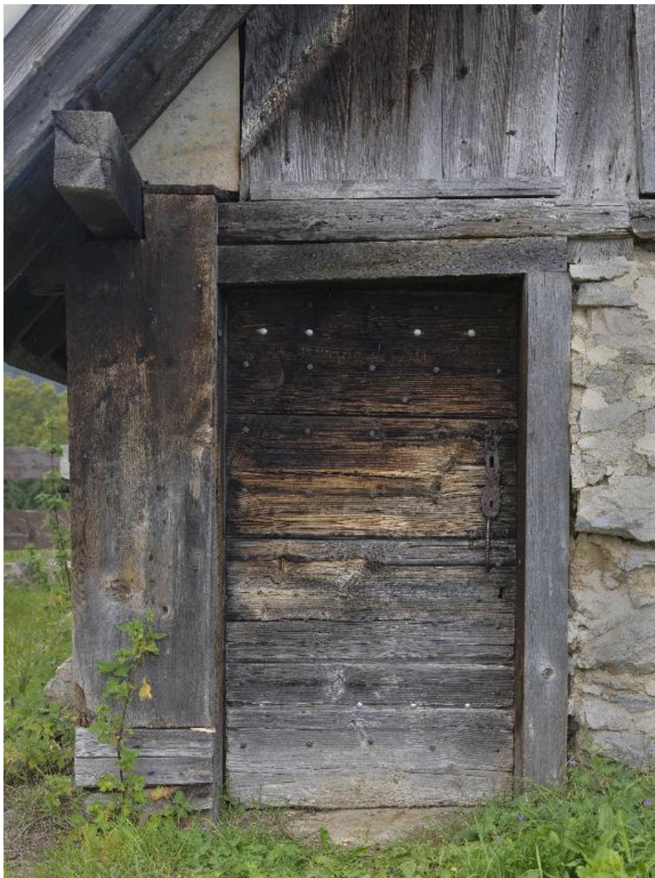
Détail de la porte du bâtiment nord.
