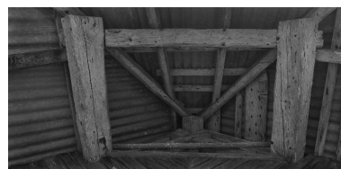
Détail de la charpente supportant une des demi-croupes. Phot. Eric Dessert IVR82_20147304315NUC
