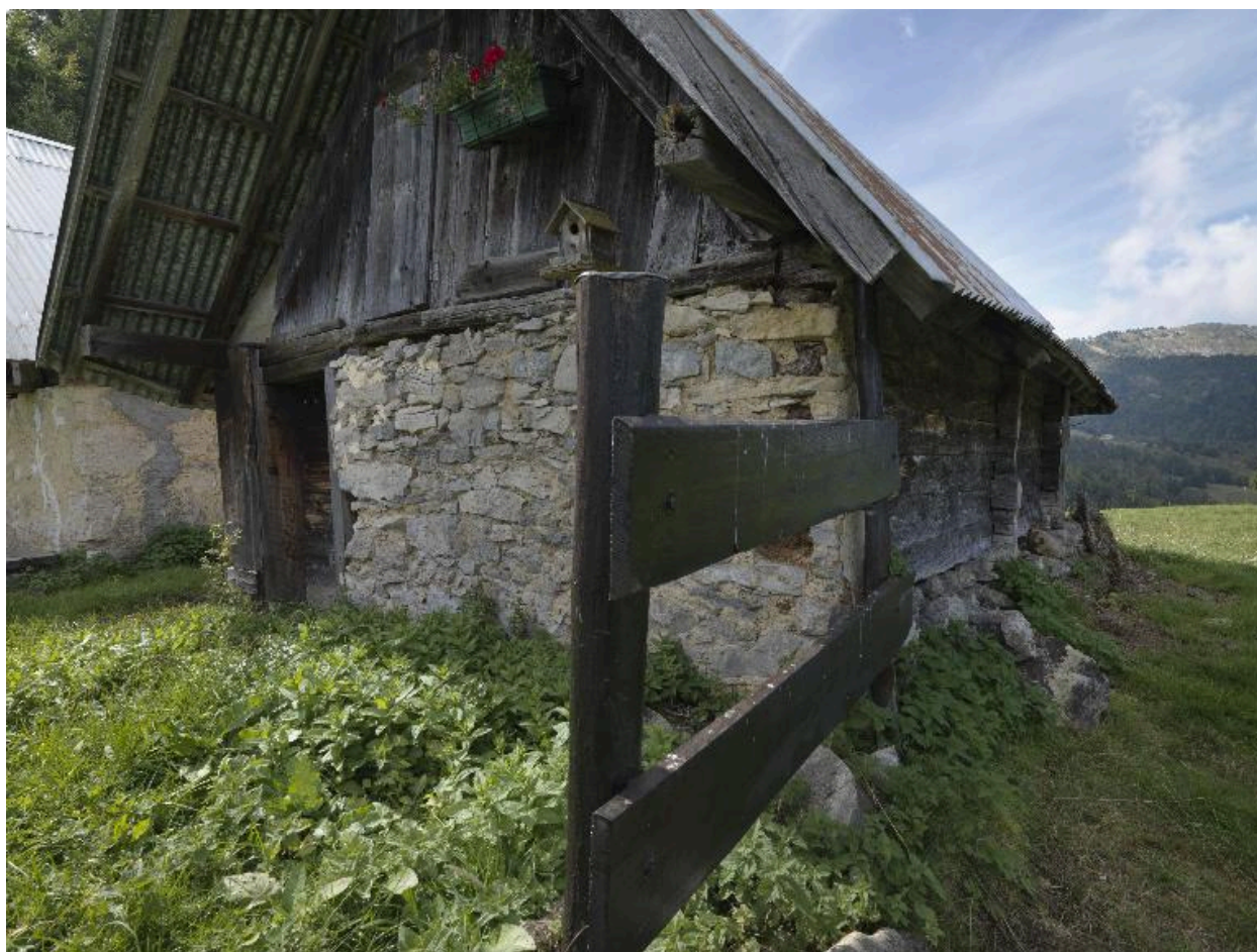
Vue de trois-quarts du bâtiment nord.
