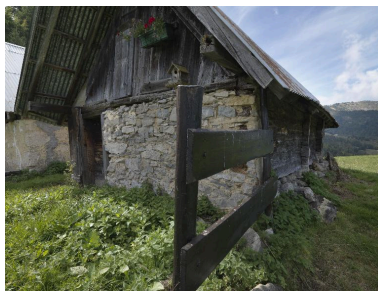
Vue de trois-quarts du bâtiment nord.
