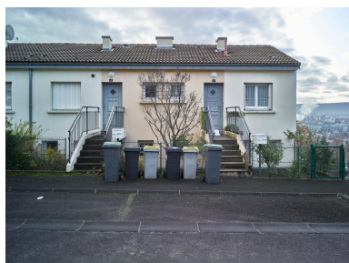
Exemple de maisons en bande avec escalier-passerelle d'accès à l'étage supérieur, depuis le côté haut de la pente. Phot. Christian Parisey IVR84_20196300397NUC4A
