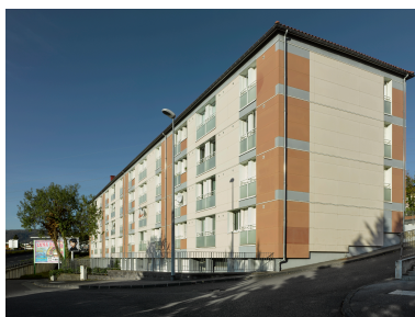
Immeuble collectif de la cité Saint-Vincent, rue du Clos-Chanturgue. Phot. Christian Parisey IVR84_20196300375NUC4A
