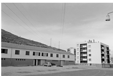
Partie sud de la cité, prise vraisemblablement peu après la fin du chantier, vers 1961-1962 : les parcelles de jardin ne sont pas encore plantées. IVR84_20236300154NUC
