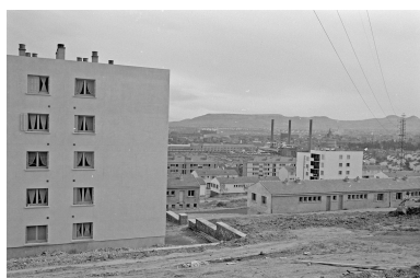
Partie haute de la cité, au nord, avec vue sur l'usine de Cataroux. Vue prise vraisemblablement peu après la fin du chantier de construction, vers 1961-1962. IVR84_20236300153NUC
