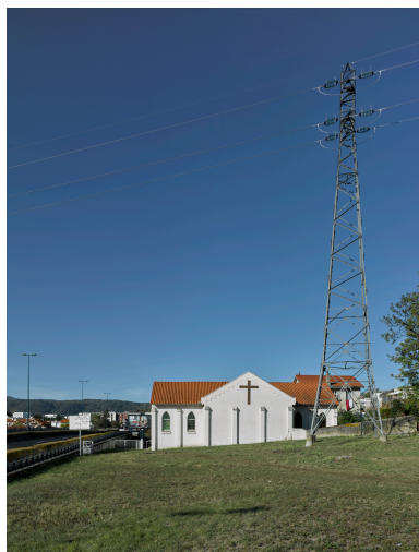
Élévation est de l'église Saint-Vincent-de-Paul, au bas de la cité (partie sud-ouest). Phot. Christian Parisey IVR84_20196300379NUC4A
