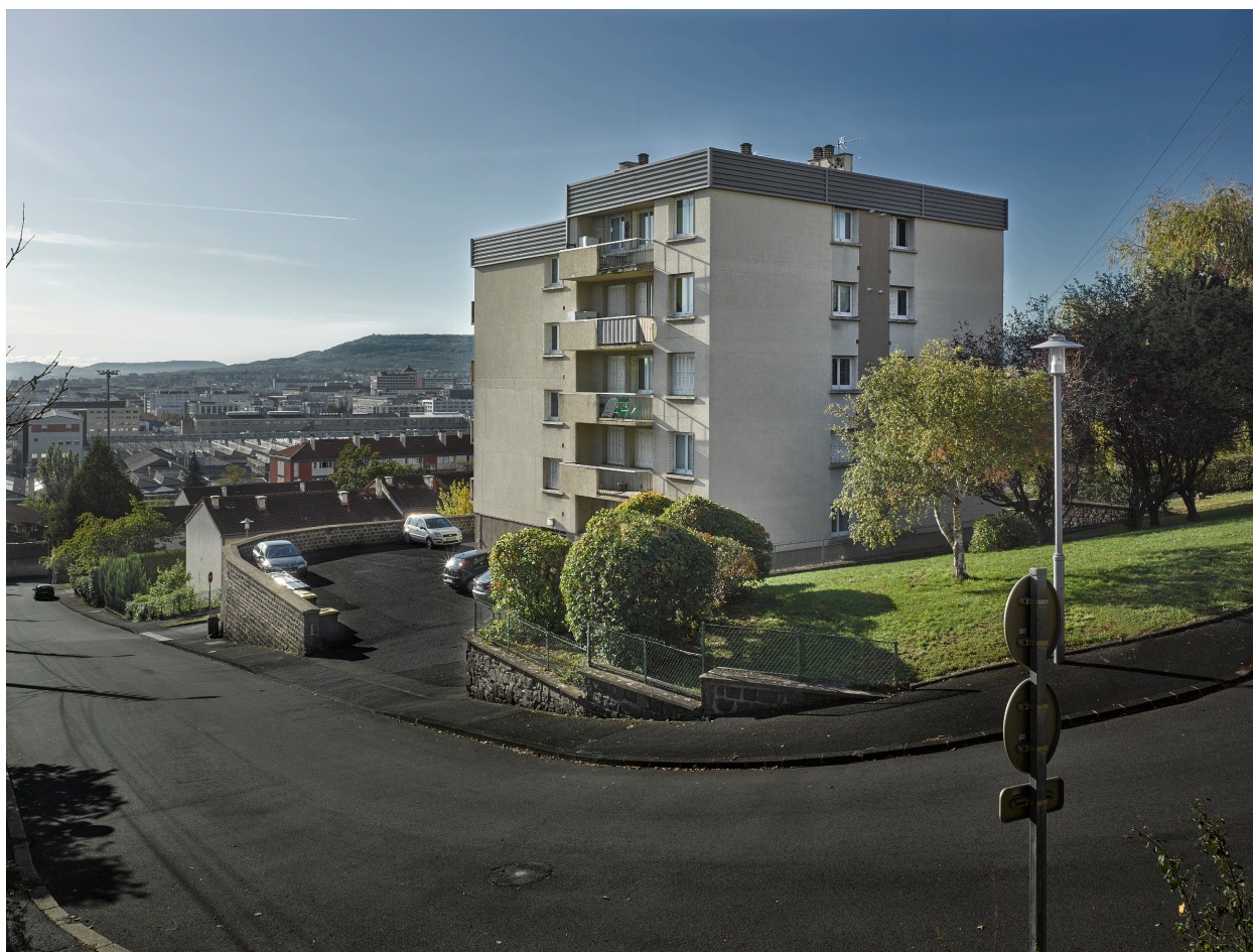
Immeuble collectif de la cité Saint-Vincent, dans la partie haute de la rue de Diane.
