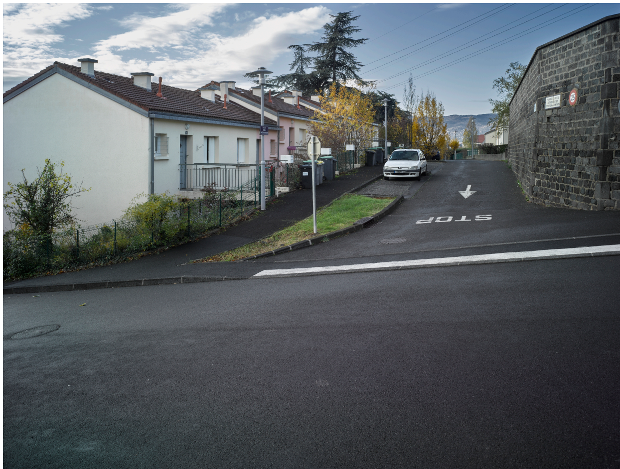
Maisons accolées en bande sur l'allée des Mésanges : élévations du côté haut de la pente avec passerelles d'accès.
