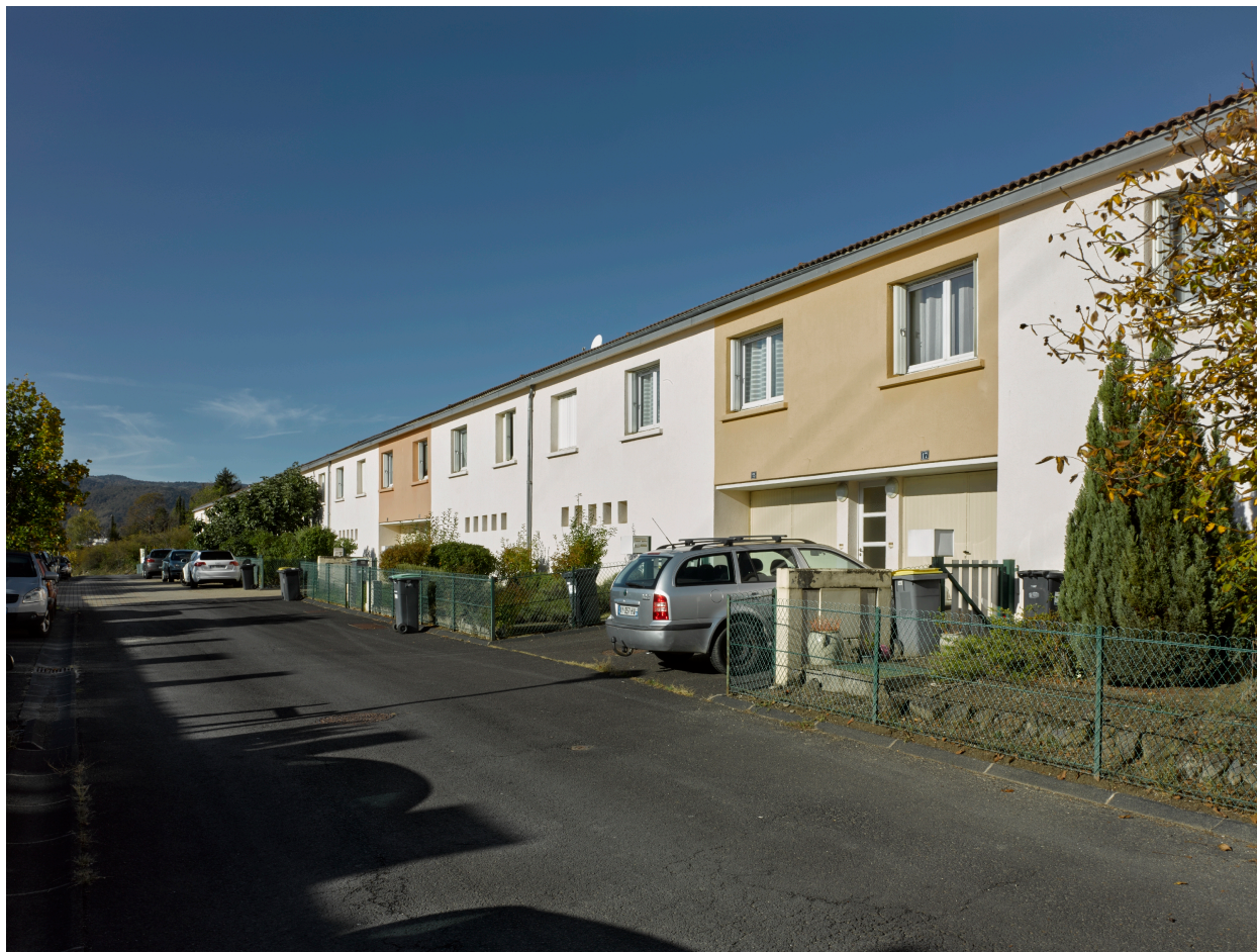
Logements en bande, allée des Fauvettes (parcelles nord, partie basse).
