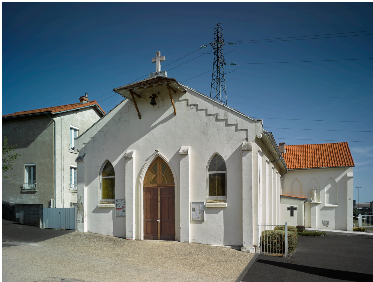
Élévation ouest de l'église Saint-Vincent-de-Paul, au bas de la cité (partie sud-ouest).
