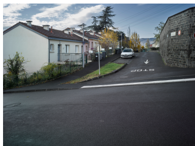
Maisons accolées en bande sur l'allée des Mésanges : élévations du côté haut de la pente avec passerelles d'accès. Phot. Christian Parisey IVR84_20196300399NUC4A
