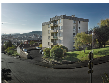
Immeuble collectif de la cité Saint-Vincent, dans la partie haute de la rue de Diane. Phot. Christian Parisey IVR84_20196300380NUC4A
