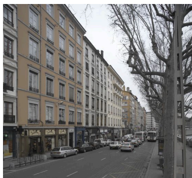
Vue générale depuis le pont de la Feuillée Phot. Eric Dessert IVR82_20056900409NUC
