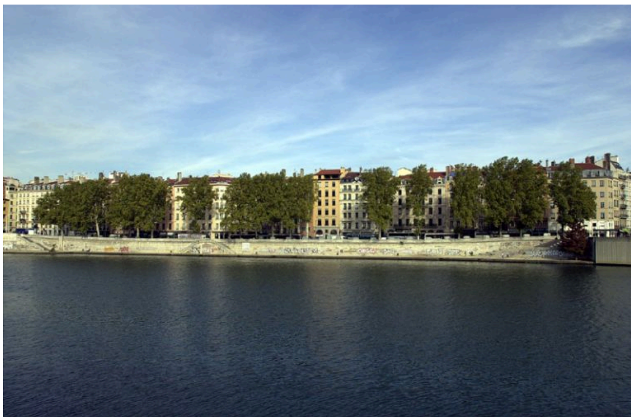
Vue générale depuis l'autre rive de la Saône
