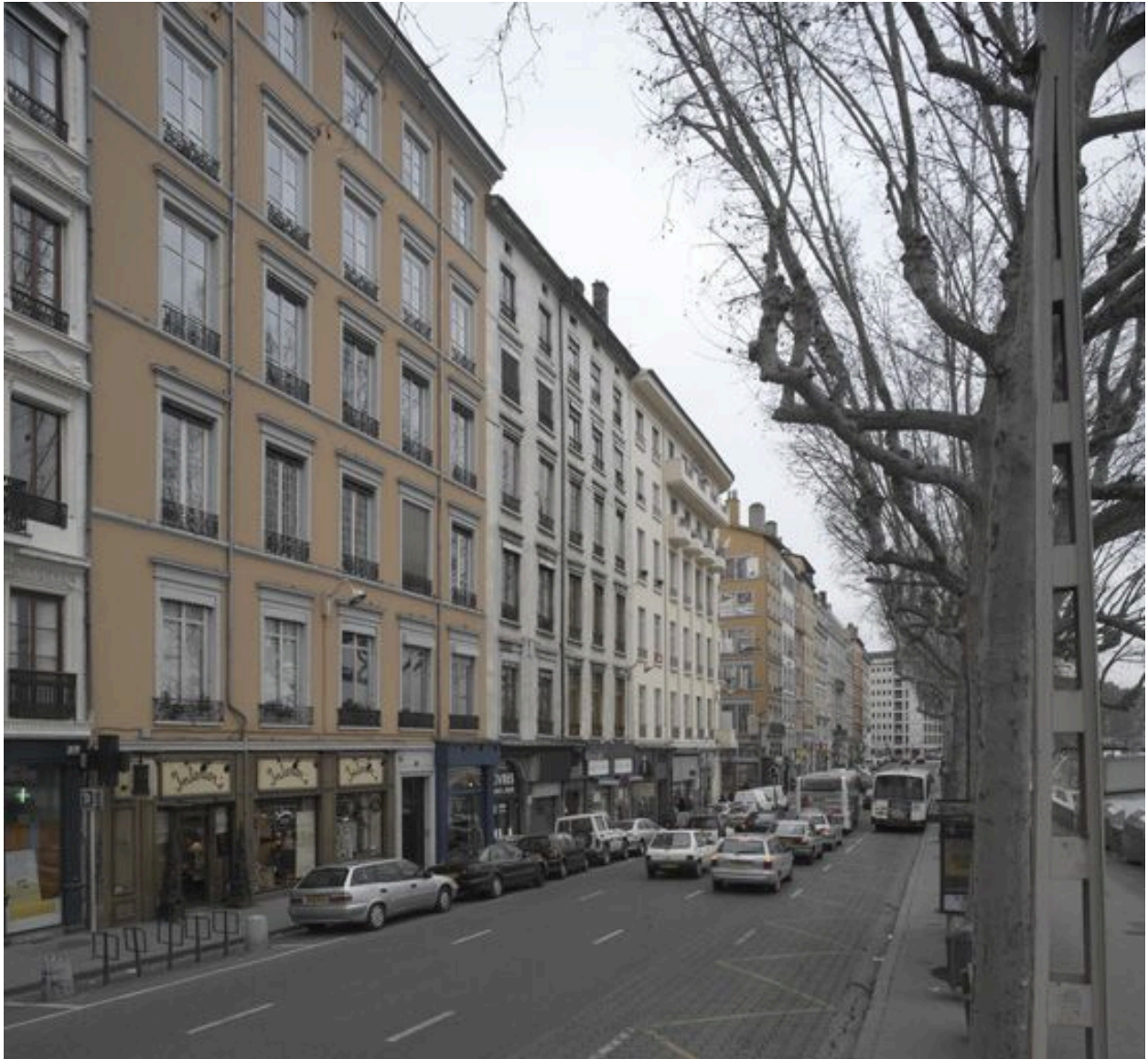
Vue générale depuis le pont de la Feuillée
