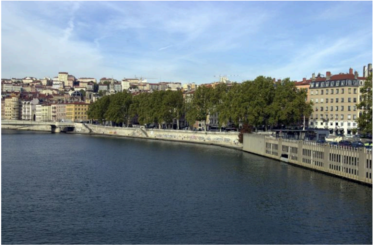
Vue générale depuis le pont Alponse-Juin
