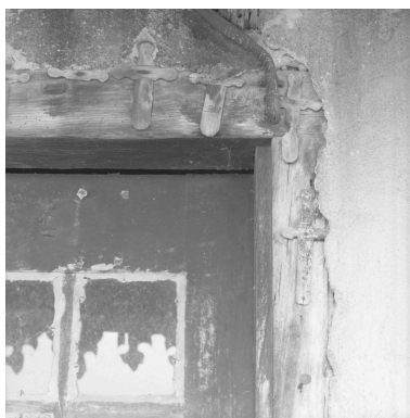
Détail de l'encadrement de la porte du rez-de-chaussée, angle droit : "croisettes". Phot. Eric Dessert IVR82_20014200618X
