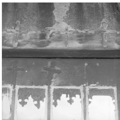
Détail de l'encadrement de la porte du rez-de-chaussée, partie centrale : "croisettes". Phot. Eric Dessert IVR82_20014200617X
