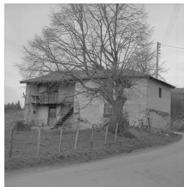
Vue d'ensemble de trois-quarts droite. Phot. Eric Dessert IVR82_20014200613X
