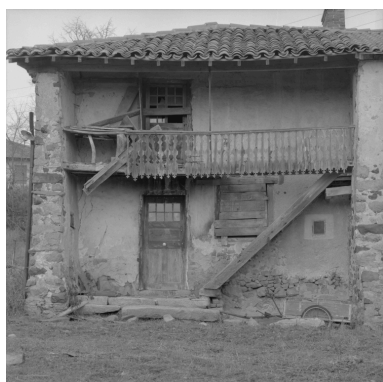
Façade antérieure, détail de la partie gauche. Phot. Eric Dessert IVR82_20014200614X
