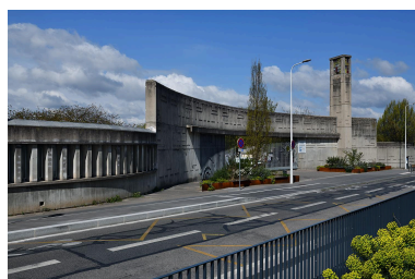
Vue d'ensemble du bureau, du portail et de la lanterne des morts Phot. Thierry Leroy IVR84_20266900467NUCAQ
