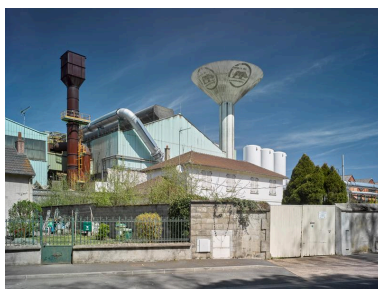
Détail vue sud : château d'eau et cheminée Phot. Christian Parisey IVR84_20180300002NUC4A
