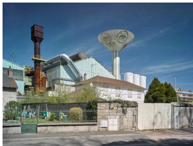
Détail vue sud : château d'eau et cheminée Phot. Christian Parisey IVR84_20180300002NUC4A
