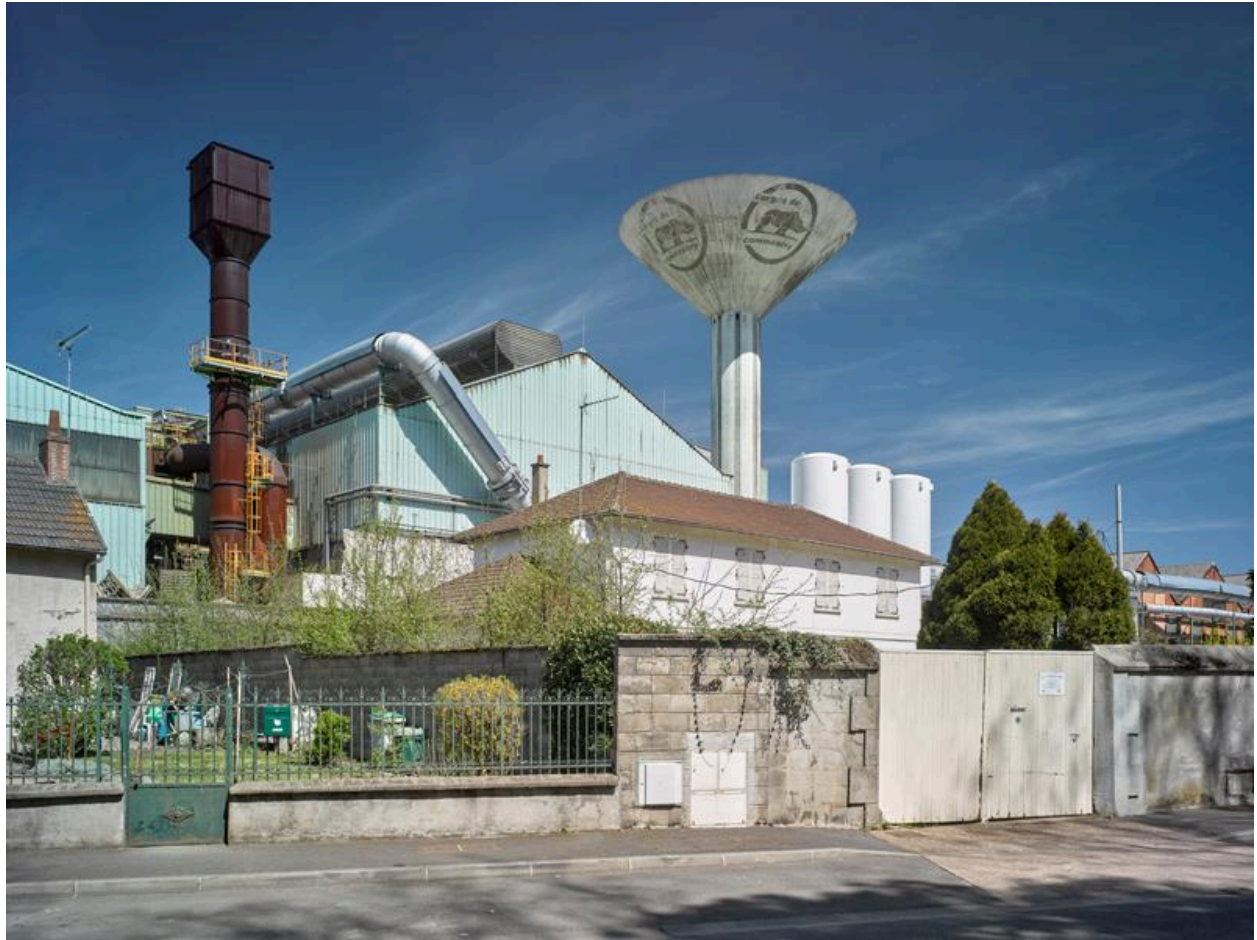
Détail vue sud : château d'eau et cheminée
