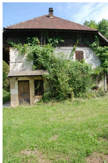
Vue d'ensemble de la façade de la parcelle 483, sur le mur pignon sud du corps de bâtiment. Phot. Thierry Monnet IVR84_20207401921NUCA
