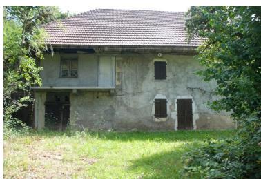
Vue d'ensemble de la façade ouest de la parcelle 957. Phot. Thierry Monnet IVR84_20207401920NUCA
