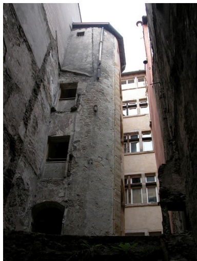
Vue générale des élévations postérieures depuis la cour du 60 rue Mercière Phot. Bernard Ducouret IVR82_20066901428NUCA
