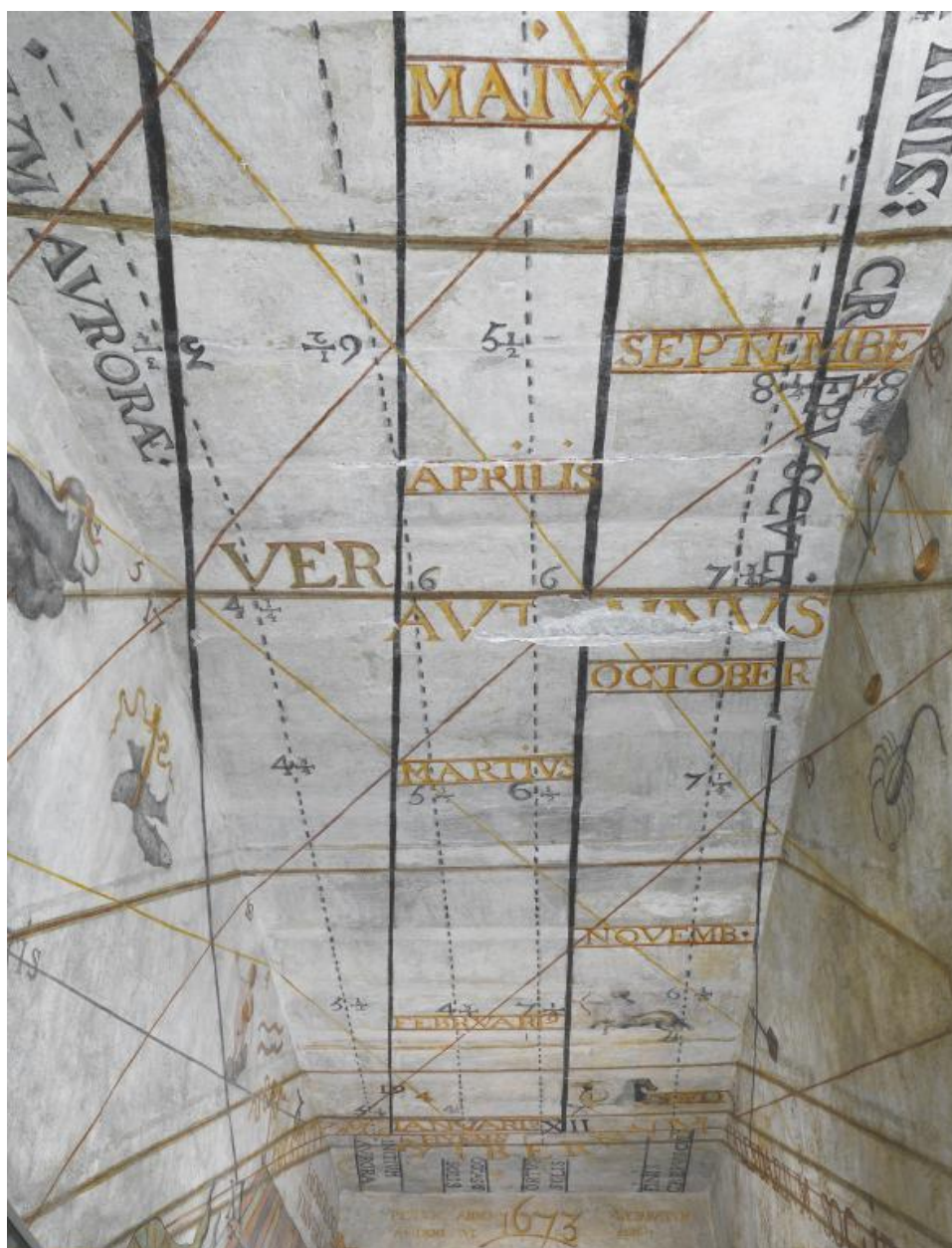
Plafond de la deuxième volée de l'escalier
