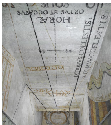
Plafond de la première volée de l'escalier Phot. Franck Trabouillet, Phot. Jérémy Cuenin IVR84_20193800085NUCAQ
