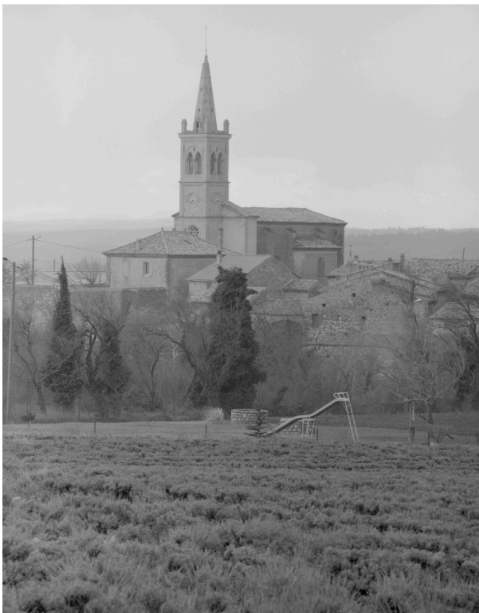
Vue générale dans le site, depuis le nord-est.
