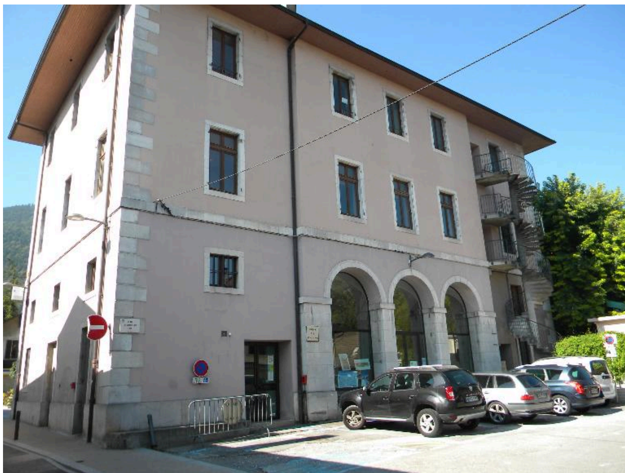
Vue de la façade arrière.
