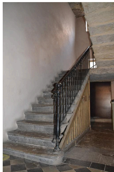
Départ escalier Phot. Noémie Caillat IVR82_20156900552NUCA
