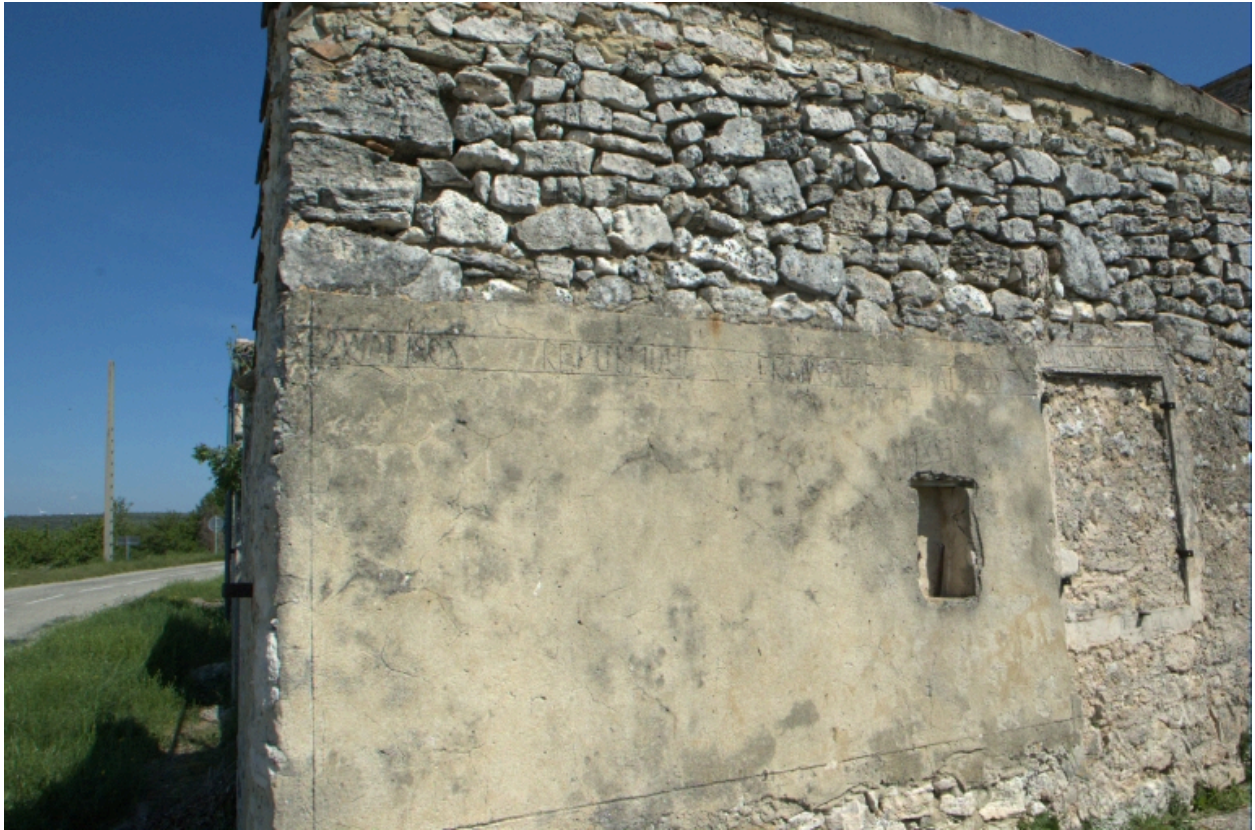
Le Fraysse. Mur enduit servant de panneau d'informations municipales, vue d'ensemble.
