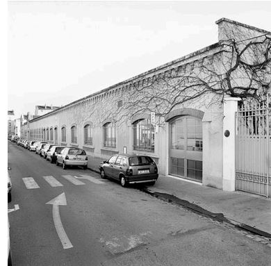
Vue générale sud-ouest Phot. Didier Gourbin IVR82_20036901857X
