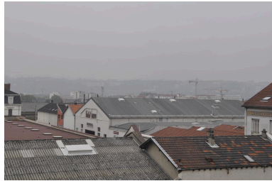
Vue d'ensemble des bâtiments de la rue de Toulon Phot. Nadine Halitim-Dubois IVR82_20136900790NUCA
