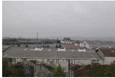
Vue des toitures Phot. Nadine Halitim-Dubois IVR82_20136900791NUCA
