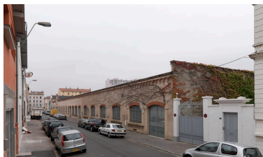
Façade principale ouest Phot. Eric Dessert IVR82_20096905627NUCA
