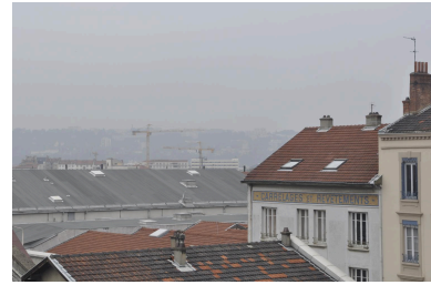
Vue d'ensemble du paysage urbain de la rue de Toulon Phot. Nadine Halitim-Dubois IVR82_20136900789NUCA
