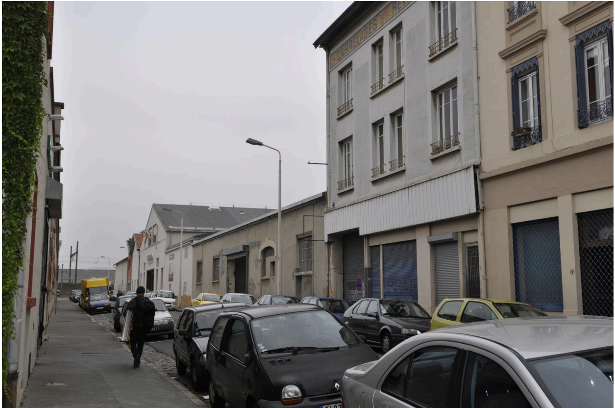
Vue de la rue de Toulon
