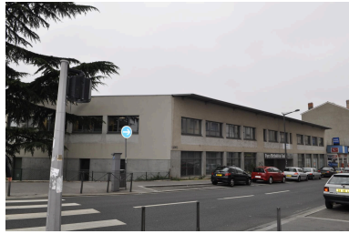
Vue des bâtiments route de Vienne Phot. Nadine Halitim-Dubois IVR82_20136900784NUCA
