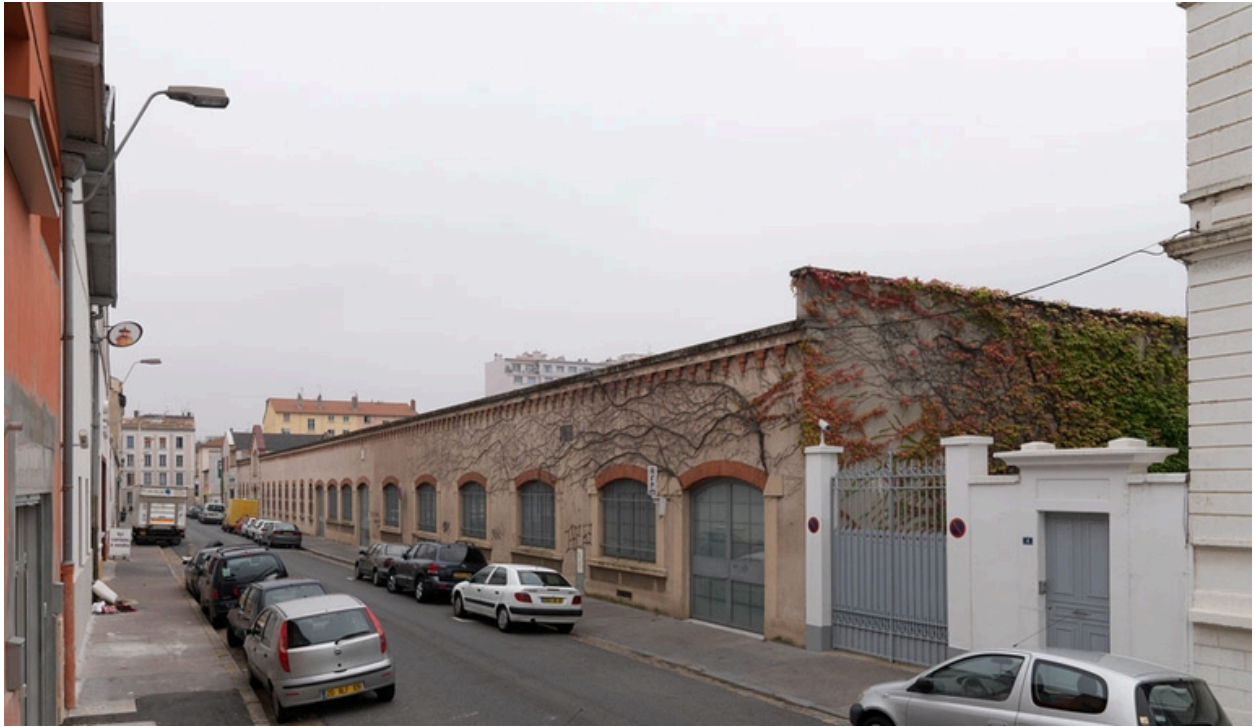
Façade principale ouest
