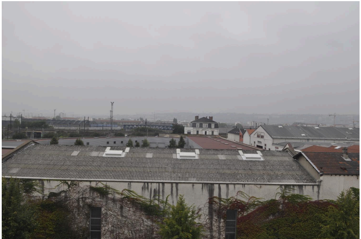
Vue des toitures
