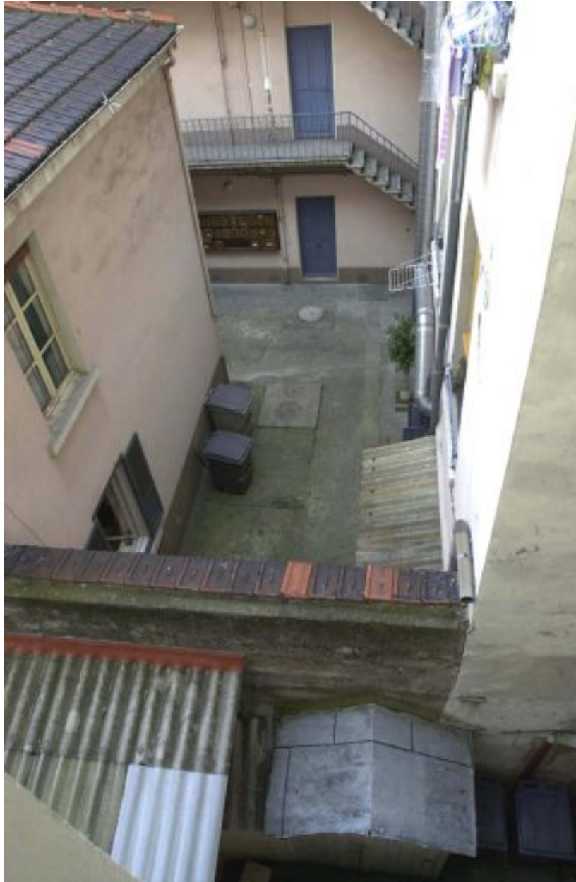
Vue d'ensemble de la cour depuis l'escalier de l'immeuble mitoyen
