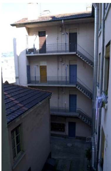
Vue des coursières de l'immeuble sur rue Phot. François Blanchetière IVR82_20016902315NUCA
