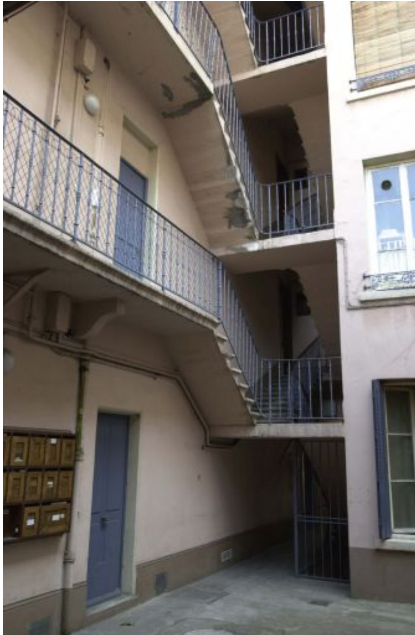
Vue de la cage ouverte de l'escalier et des accès aux coursières
