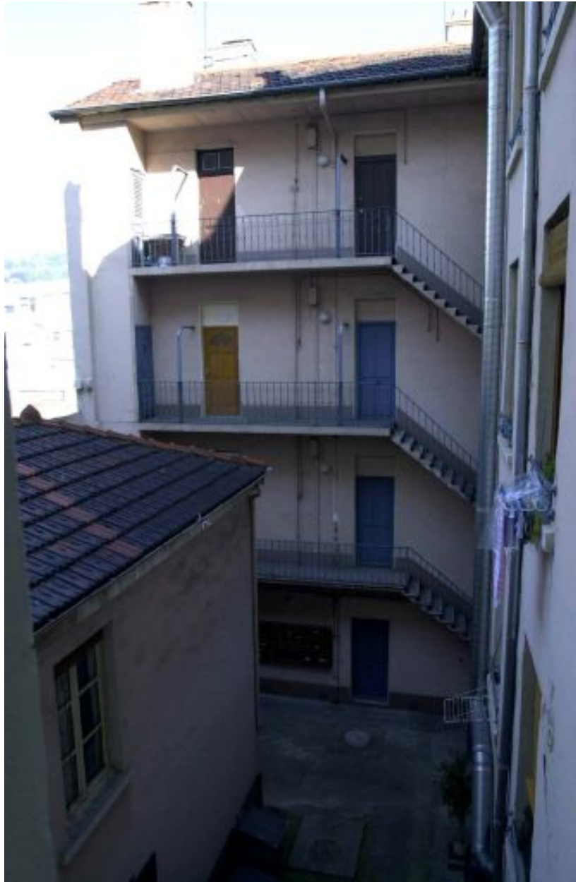
Vue des coursières de l'immeuble sur rue
