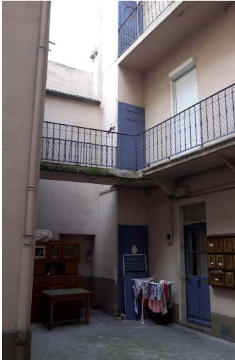
Vue des coursières et de la passerelle vers l'immeuble sur cour
