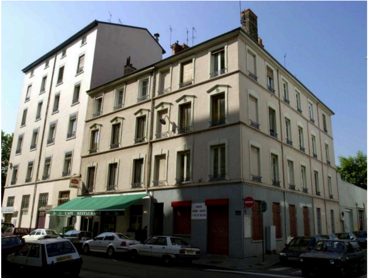
Vue d'ensemble, angle des rues Bichat et Seguin
