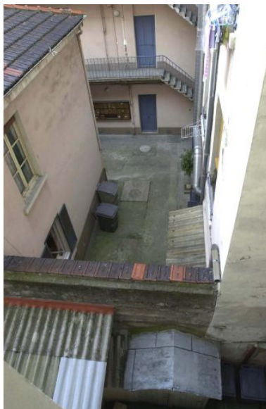
Vue d'ensemble de la cour depuis l'escalier de l'immeuble mitoyen Phot. François Blanchetière IVR82_20016902314NUCA
