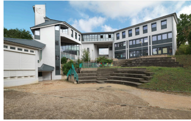
Vue de la cour intérieure Phot. Thierry Leroy IVR84_20203800455NUCAQ
