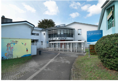
Vue de l'entrée Phot. Thierry Leroy IVR84_20203800454NUCAQ
