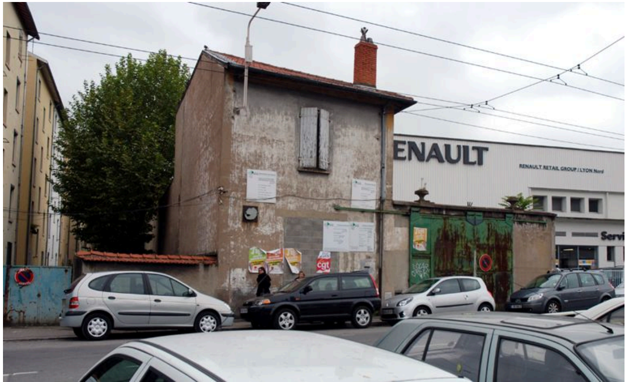
Vue de l'élévation latérale nord
