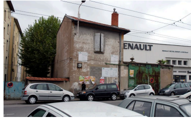
Vue de l'élévation latérale nord Phot. Catherine Guégan IVR82_20086902837NUCA
