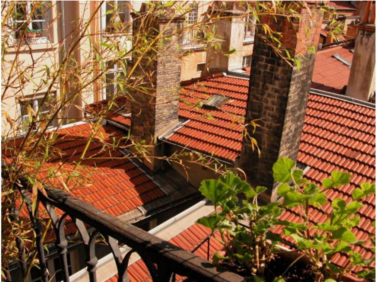
Toits et cour vus depuis l'escalier principal du 3, quai de la Pêcherie
