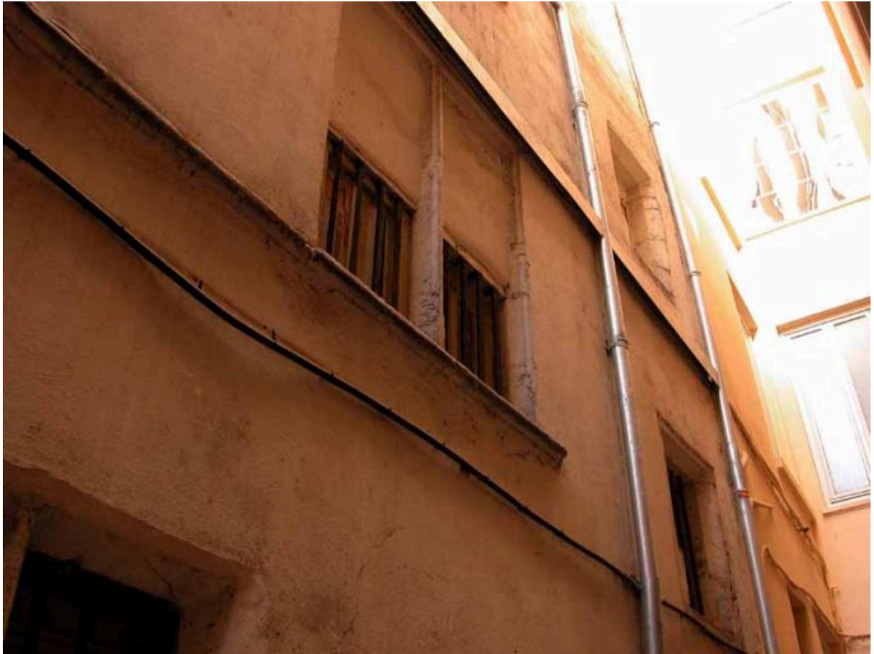
Façade sur l'impasse, détail de la croisée du 1er étage
