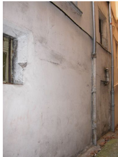
Façade sur l'impasse, rez-de-chaussée et ancienne porte d'entrée Phot. Bernard Ducouret IVR82_20046900576NUCA
