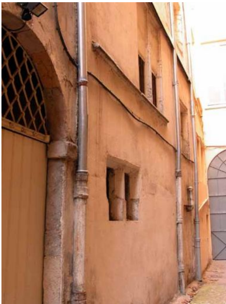
Façade sur l'impasse, vue générale des 2 premiers niveaux
