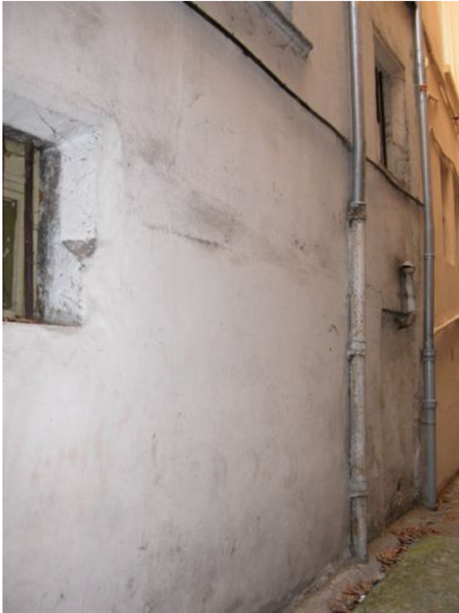
Façade sur l'impasse, rez-de-chaussée et ancienne porte d'entrée
