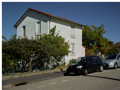
Maison de type T des années 1920, à l'angle de la rue des Rivaux et de la rue des Meuniers (partie sud de la cité de Lachaux). Phot. Christian Parisey IVR84_20196300350NUC4A
