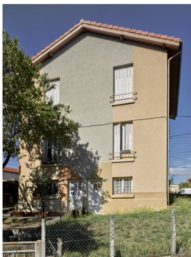
Maison double de type T des années 1920, allée de la Côte (partie nord de la cité de Lachaux) : pignon en bas de pente. Phot. Christian Parisey IVR84_20196300339NUC4A
