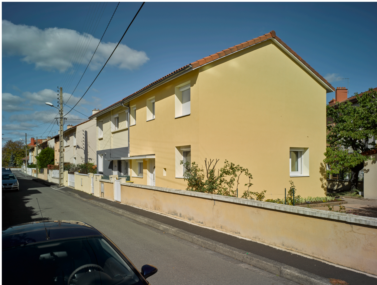
Maisons doubles de la rue des Troènes (partie nord de la cité de Lachaux), datant des années 1956-1957.
