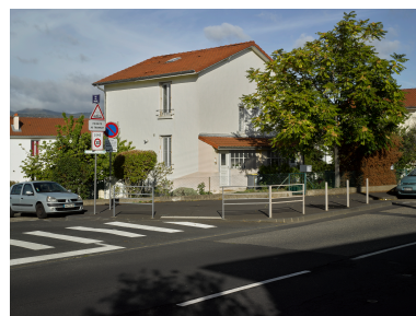
Maison double de type T des années 1920, à l'angle de la rue des Rivaux et de la rue des Meuniers (partie sud de la cité de Lachaux). Phot. Christian Parisey IVR84_20196300336NUC4A
