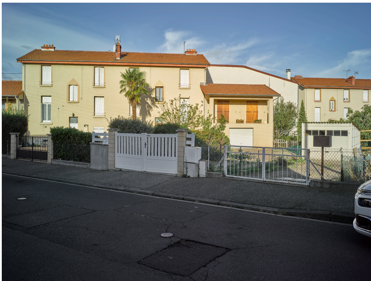
Habitations quadruples de type O des années 1920, rue Pierre-Puget (partie sud de la cité de Lachaux). L'un des logements de l'habitation au 1er plan a été agrandi sur le côté (pièce sur garage).
