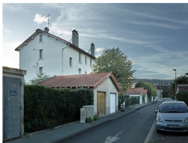
Immeuble "employés" (1925) avec garages, allée des Troènes (partie nord de la cité de Lachaux). Phot. Christian Parisey IVR84_20196300348NUC4A
