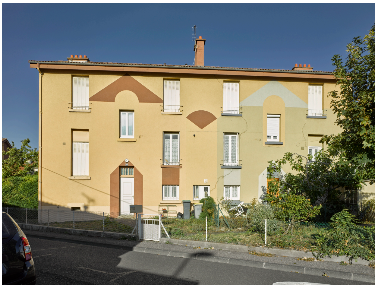
Habitation quadruple de type O des années 1920, allée de Rochefeuille (partie nord de la cité de Lachaux).
