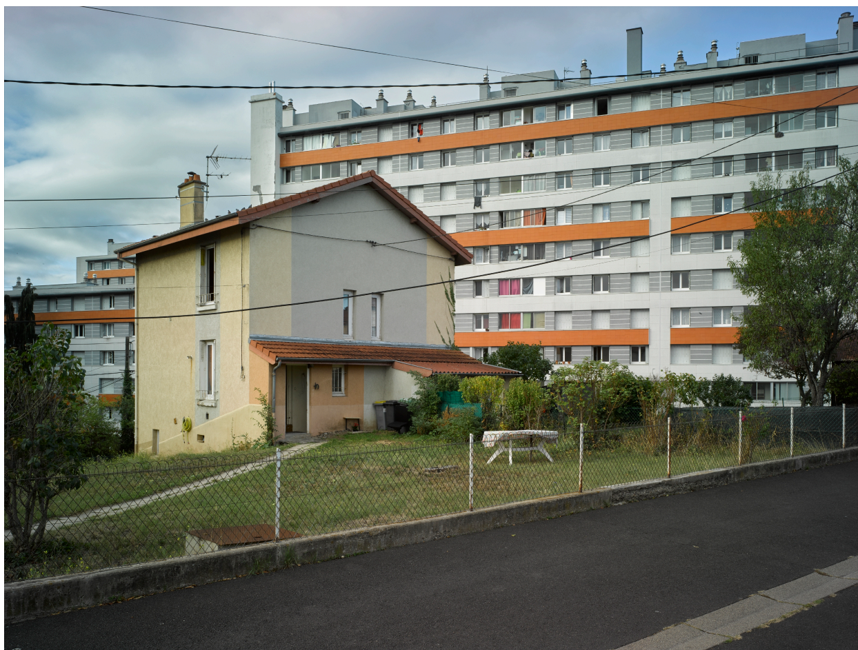
Maison double de type T des années 1920, allée de la Côte (partie nord de la cité de Lachaux) : pignon en haut de pente.
