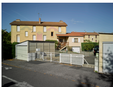
Habitations de type O des années 1920, allée de la Plaine (partie nord de la cité de Lachaux). L'un des logements de l'habitation au 1er plan a été agrandi sur le côté (pièce sur garage). Phot. Christian Parisey IVR84_20196300344NUC4A
