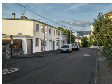
Maisons doubles accolées de type "Bezance" des années 1962-1964, allée de Rochefeuille (partie nord de la cité de Lachaux). Phot. Christian Parisey IVR84_20196300349NUC4A
