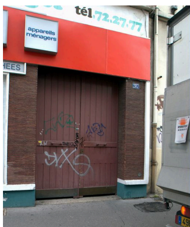
La porte du passage cochier Phot. Maryannick Chalabi IVR82_20086900757NUCA
