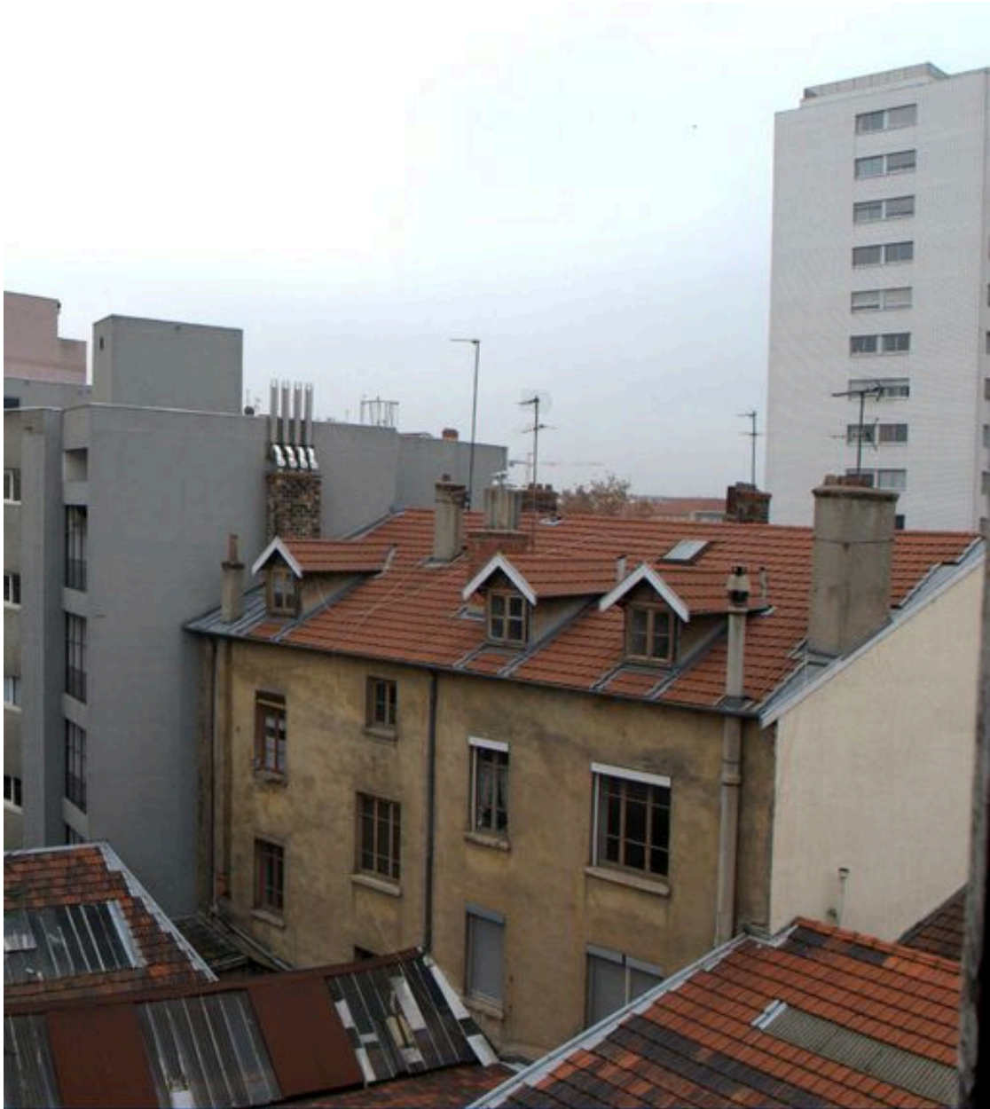
Elévation postérieure depuis le nord-est
