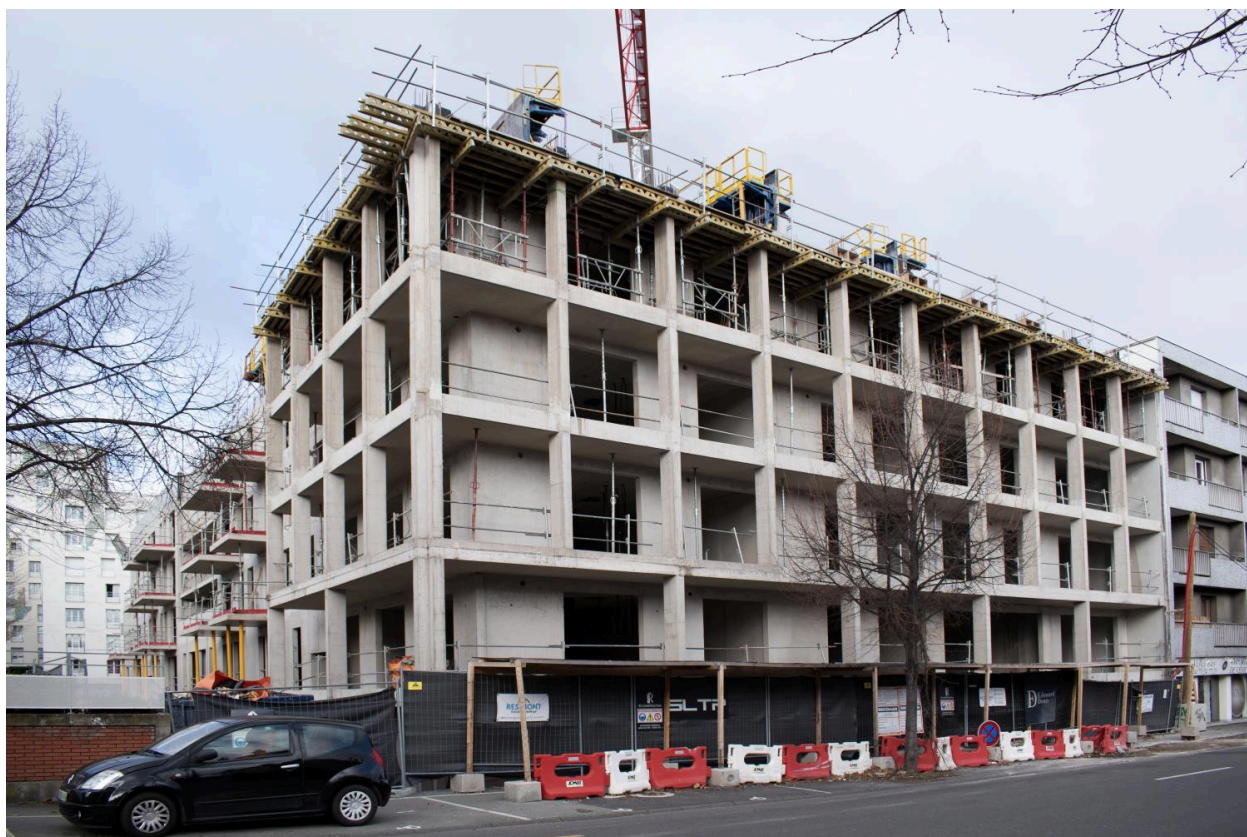
Immeuble en construction, boulevard Lavoisier
