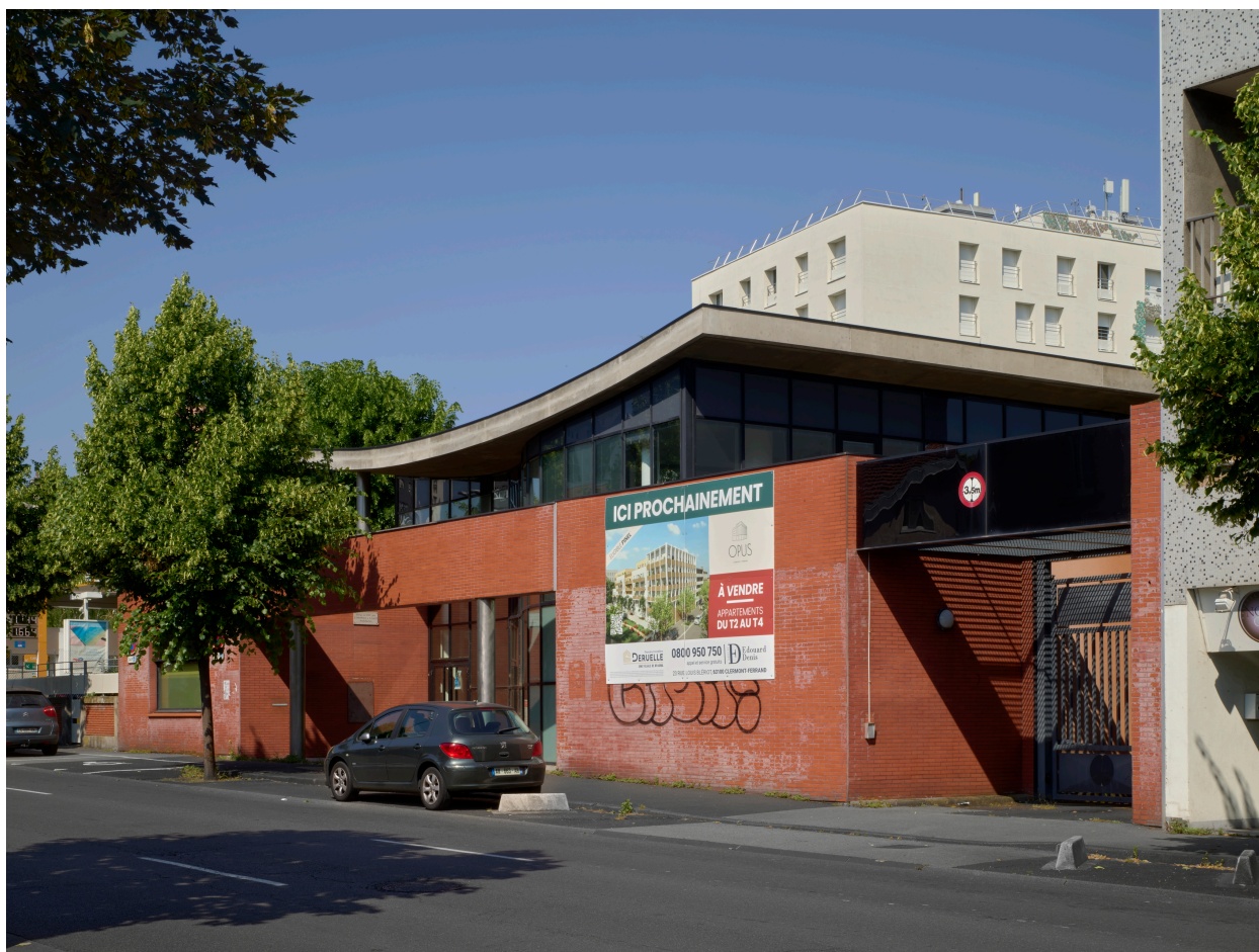
Elévation sur le boulevard Lavoisier
