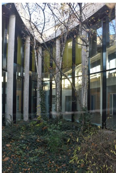
Vue du patio vitré dans le hall
