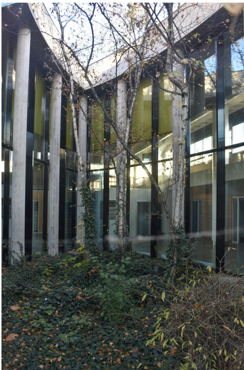
Vue du patio vitré dans le hall
