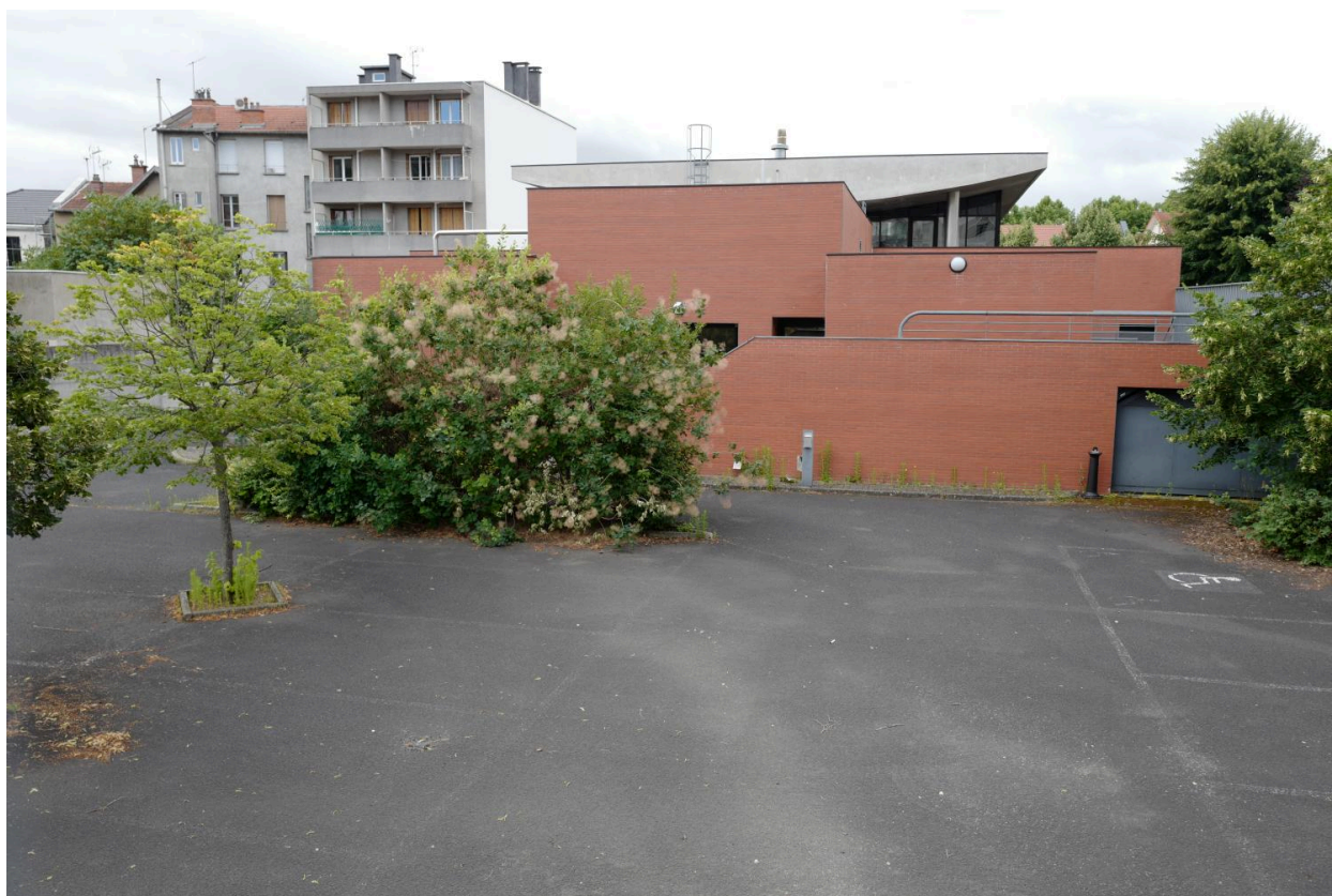
Elévation septentrionale, arrière du bâtiment, 132 boulevard Lavoisier
