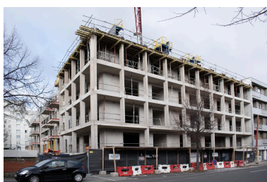
Immeuble en construction, boulevard Lavoisier Phot. François-Nicolas L'Hardy IVR84_20256300216NUCA
