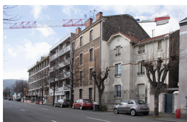
Façades sur le boulevard Lavoisier Phot. François-Nicolas L'Hardy IVR84_20256300196NUCA
