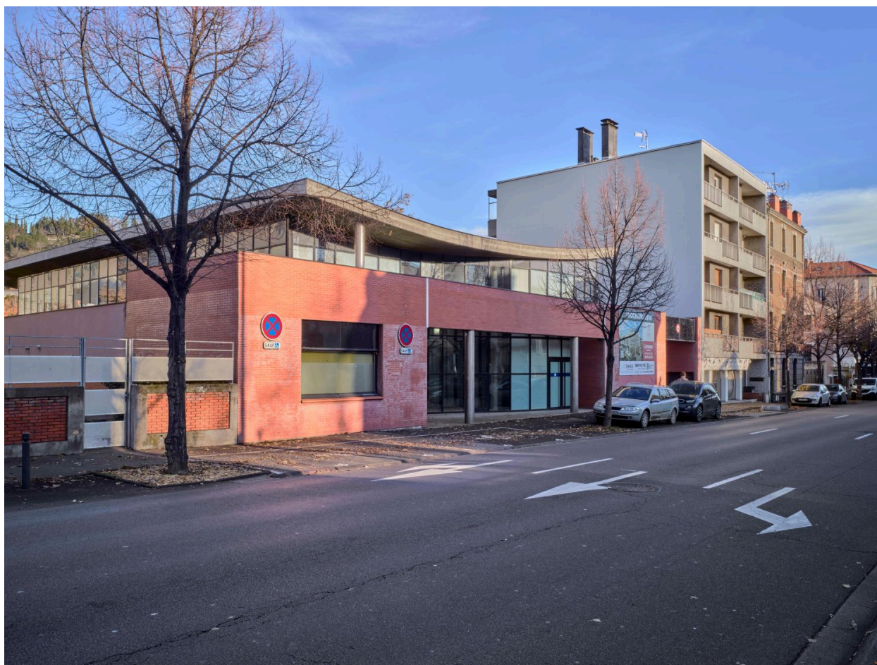
Elévation principale sur le boulevard
