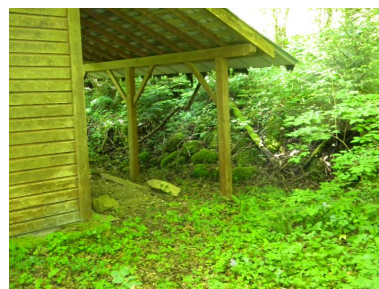
Vue des vestiges d'un bâtiments appartenant aux habitants du hameau de Montgellaz (2008 C1 28). Phot. Jérôme Daviet IVR82_20147400488NUCA
