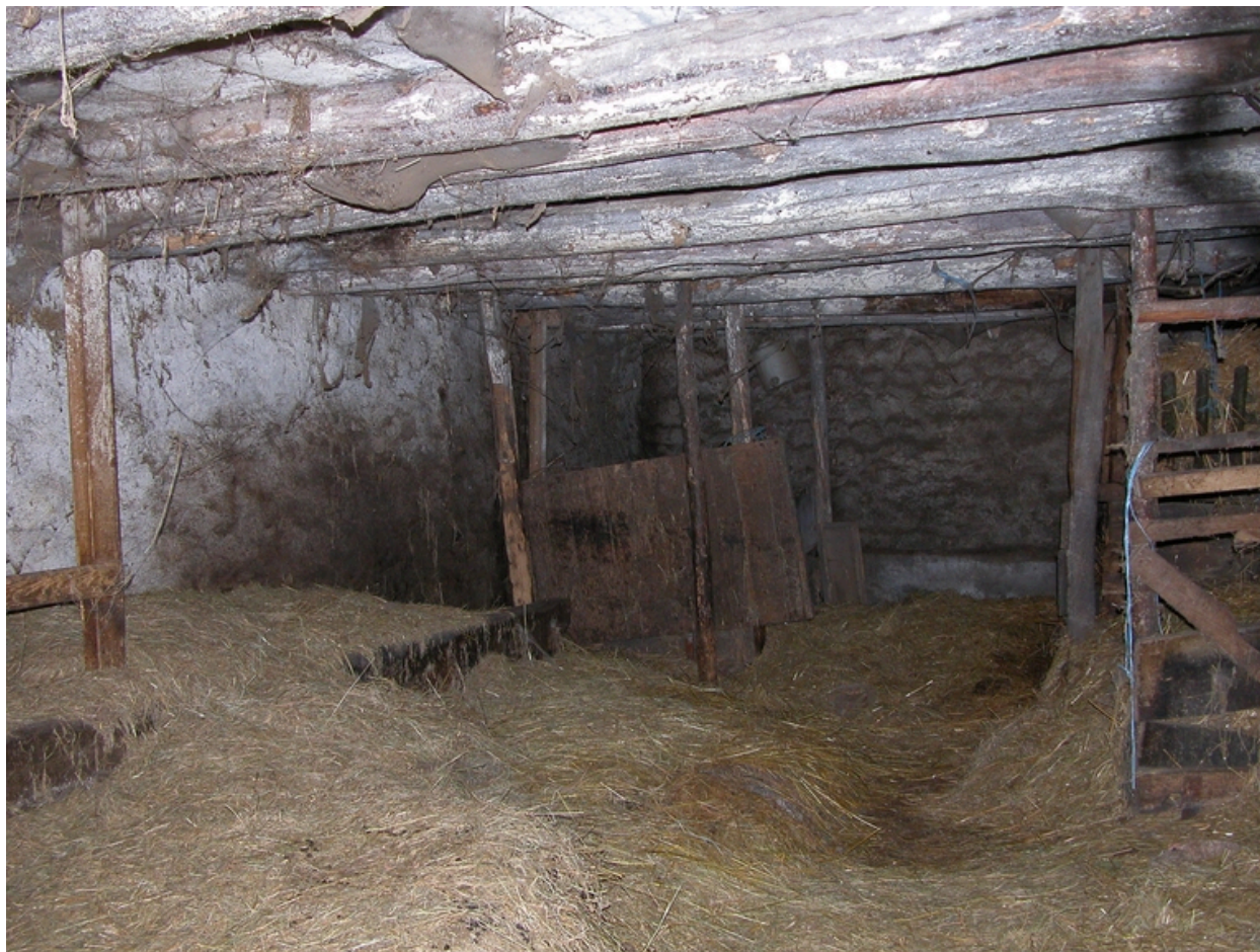
Vue intérieure de l'étable.
