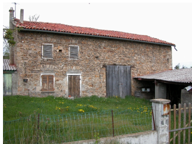
Vue générale. Phot. Thierry Monnet IVR82_20114202283NUCA
