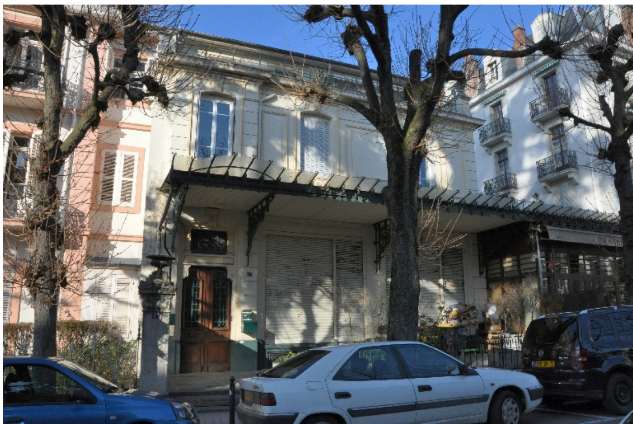
Façade sud vue de trois-quart
