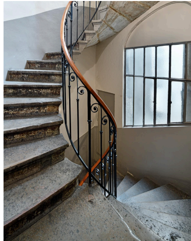
L'escalier : une volée Phot. Thierry Leroy IVR84_20226900519NUCAQ
