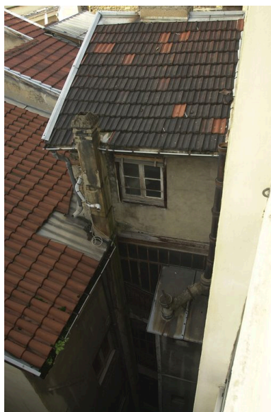
La cage d'escalier depuis l'escalier de l'immeuble sis 10 rue de l'Ancienne-Préfecture Phot. Véronique Belle IVR82_20076901208NUCA
