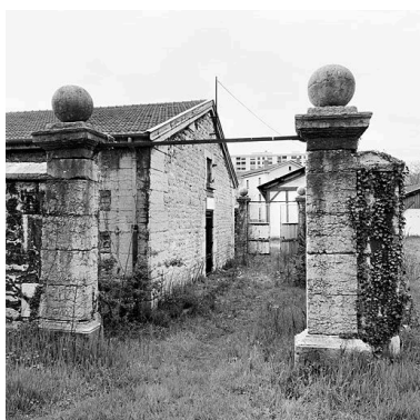
Vue du mur d'entrée depuis un des portails Phot. Didier Gourbin IVR82_20046904287X
