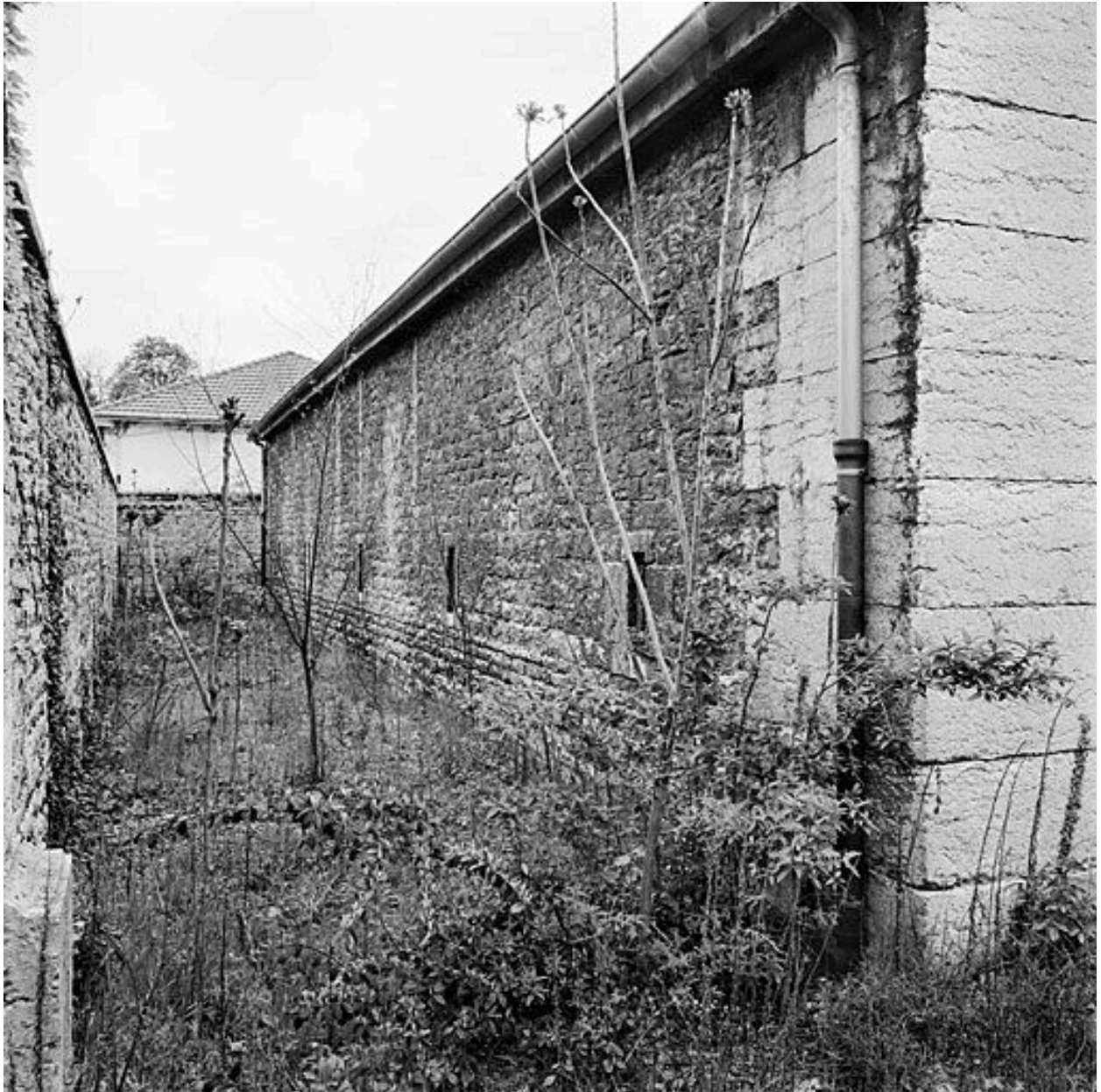
Vue de l'espace entre le mur et la chemise
