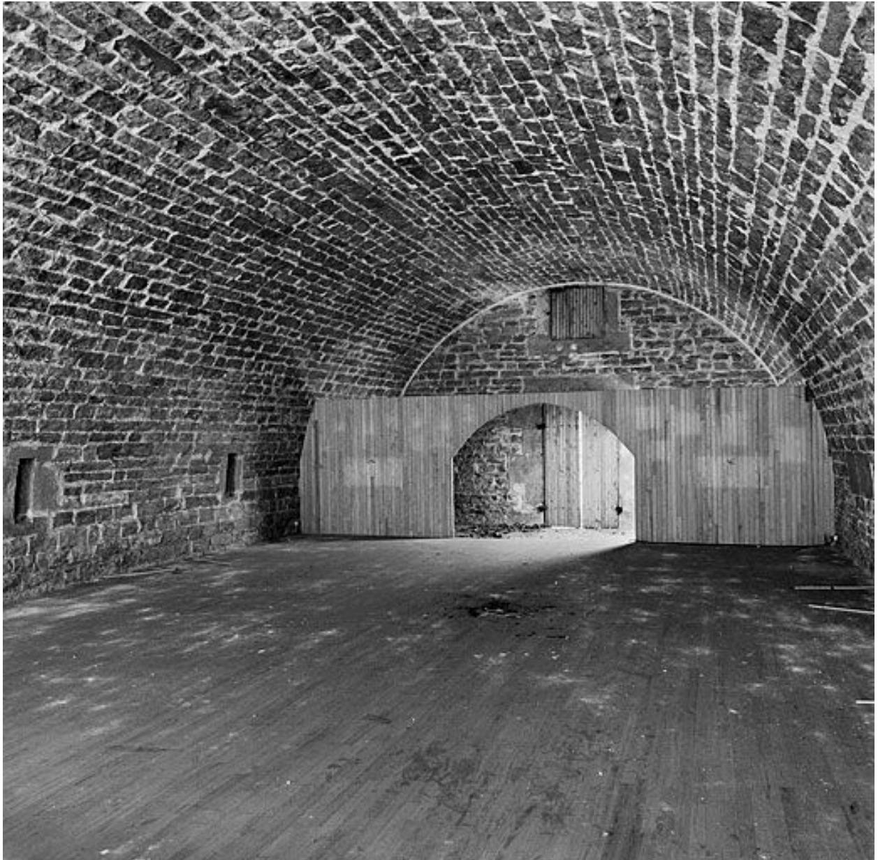
Vue de la voûte vers l'entrée
