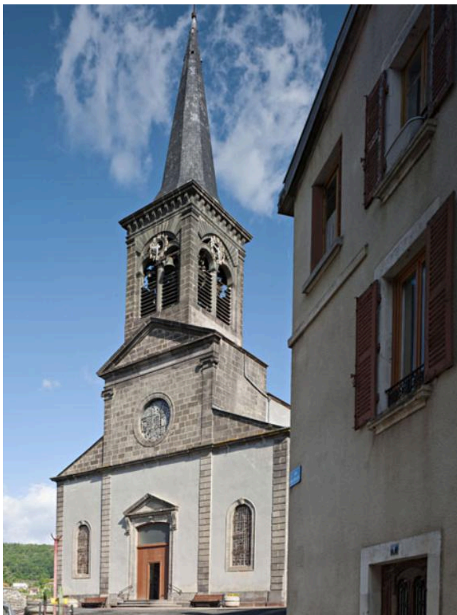
Vue générale de la façade occidentale.
