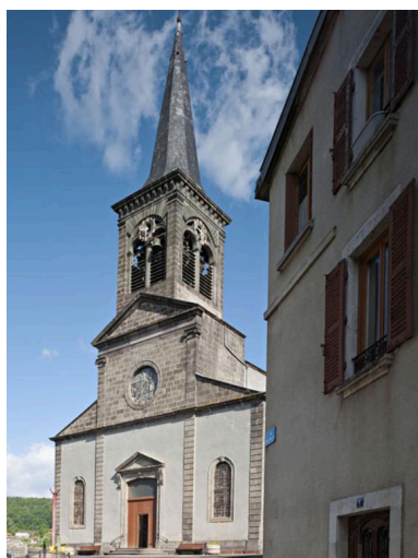
Vue générale de la façade occidentale.
