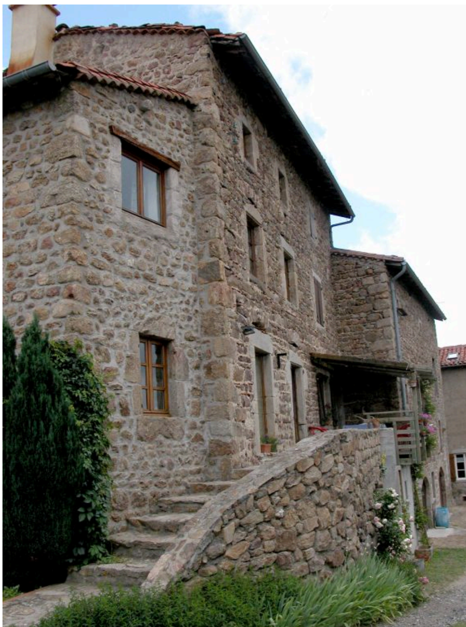
Vue d'ensemble en enfilade de la façade du logis sur cour.
