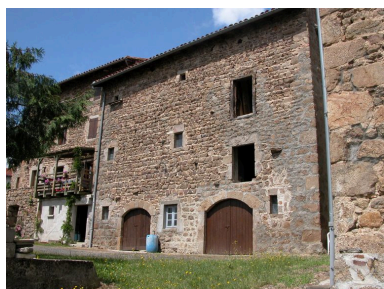
Vue générale Phot. Thierry Monnet IVR82_20124200709NUCA
