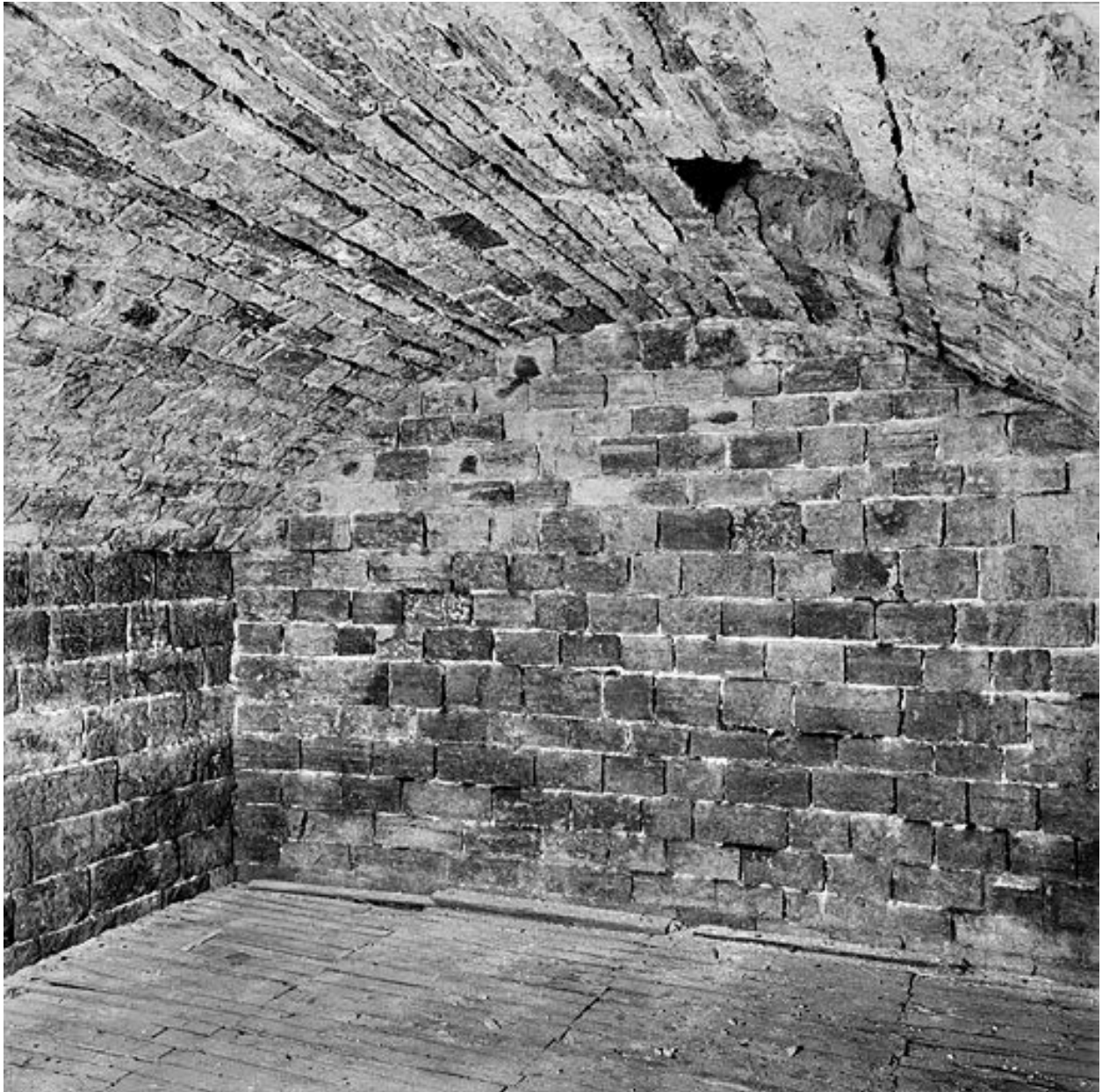
Chambre de tir : mur du fond et cheminée d'aération
