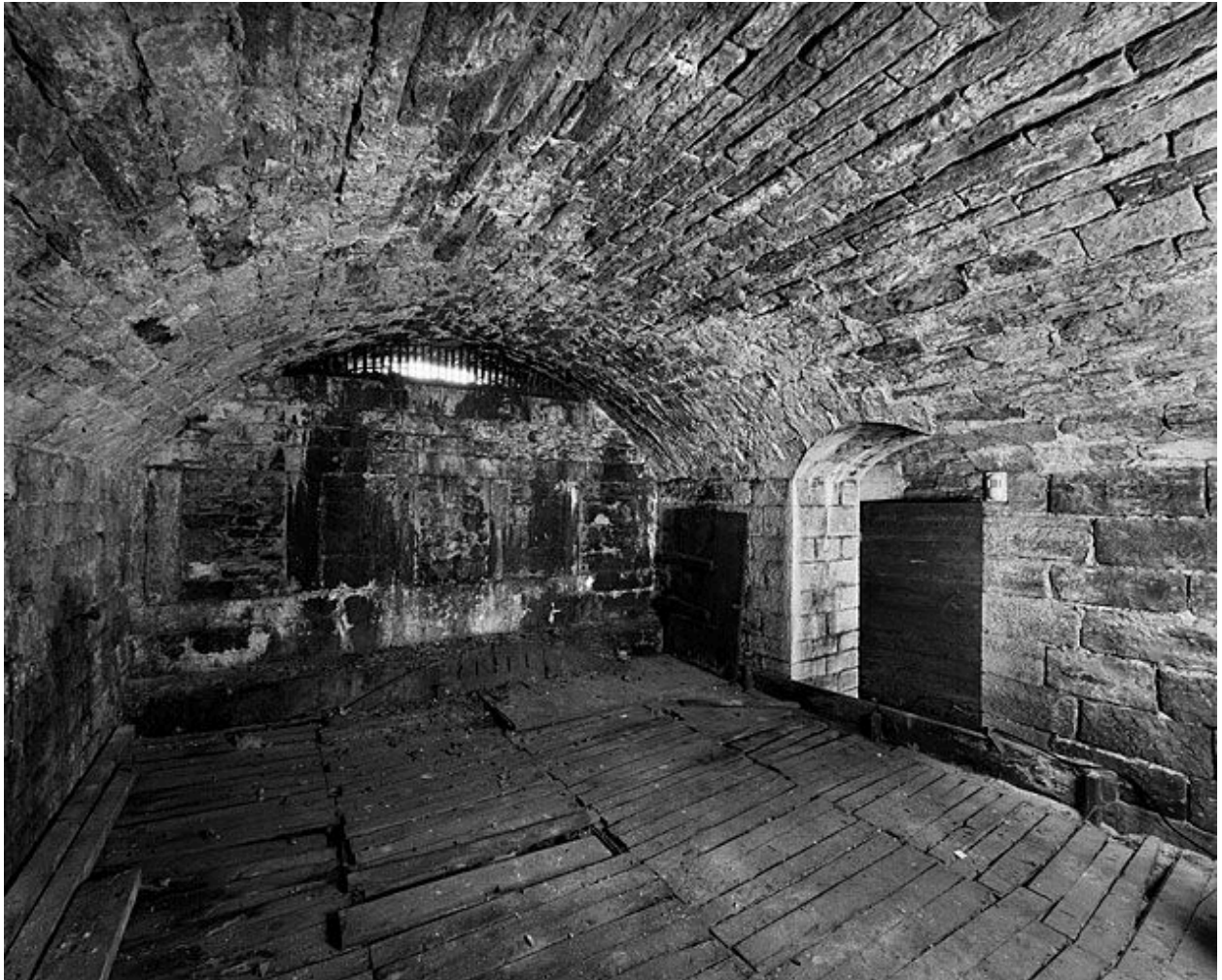
Intérieur de la chambre de tir vers les ouvertures murées
