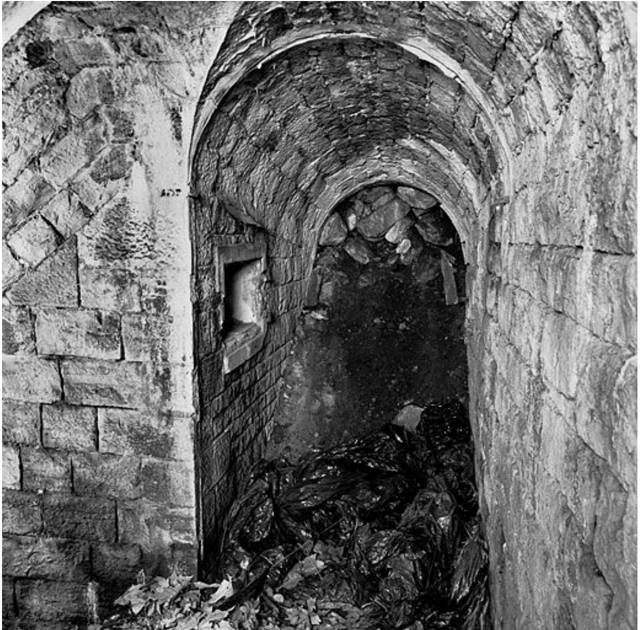
Fond du couloir d'entrée
