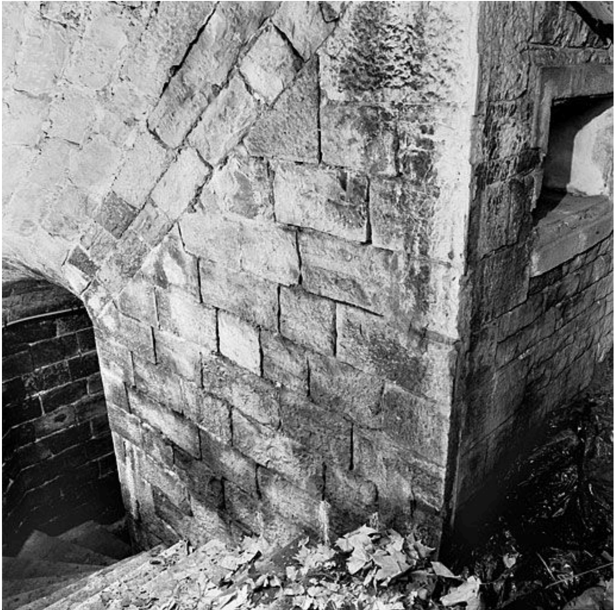
Escalier vers la chambre de tir
