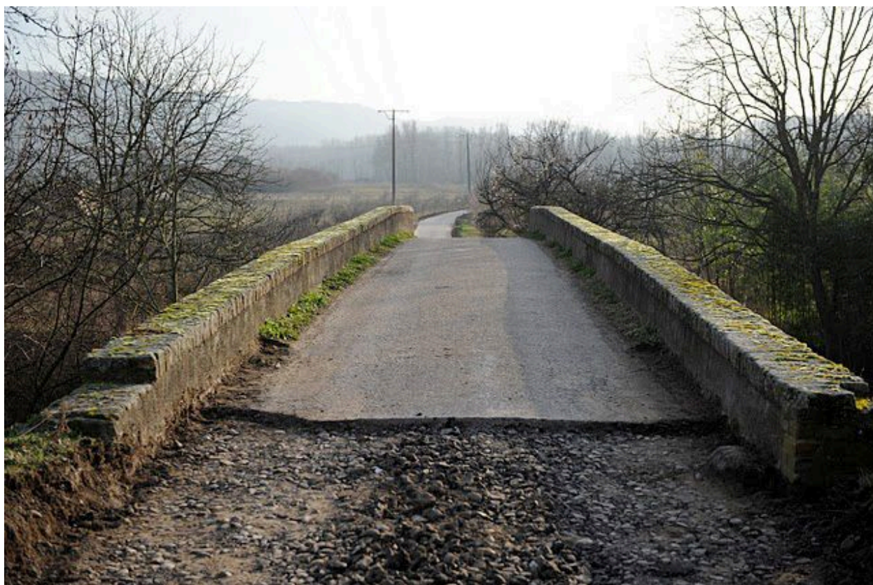
Vue sur la chaussée
