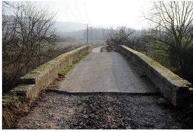
Vue sur la chaussée Phot. G. Gellert IVR82_20106907115NUCA
