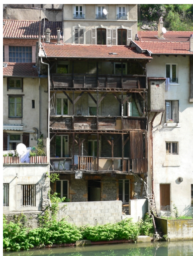
Façade sur Gère Phot. Isabelle Dupuis IVR82_20093800454NUCA
