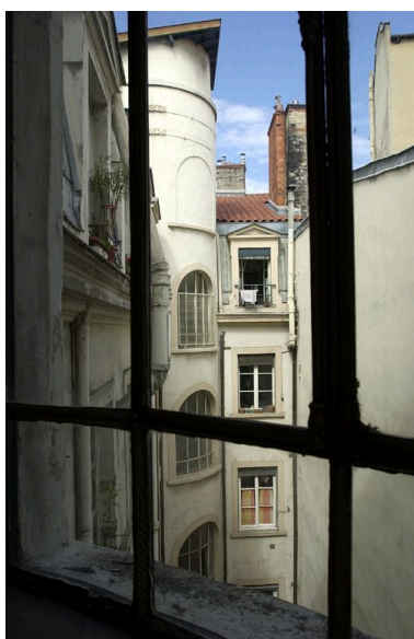
La cour depuis la cage d'escalier du 5 rue des Archers Phot. Véronique Belle IVR82_20066901590NUCA
