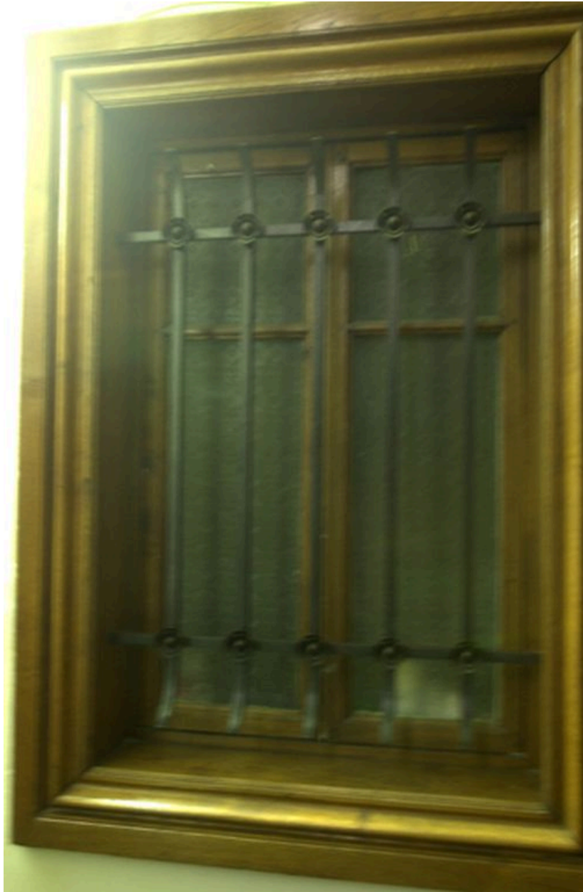
Détail de baie ouvrant sur l'escalier
