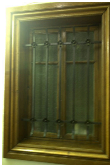
Détail de baie ouvrant sur l'escalier Phot. Maryannick Chalabi IVR82_20046904369NUCA
