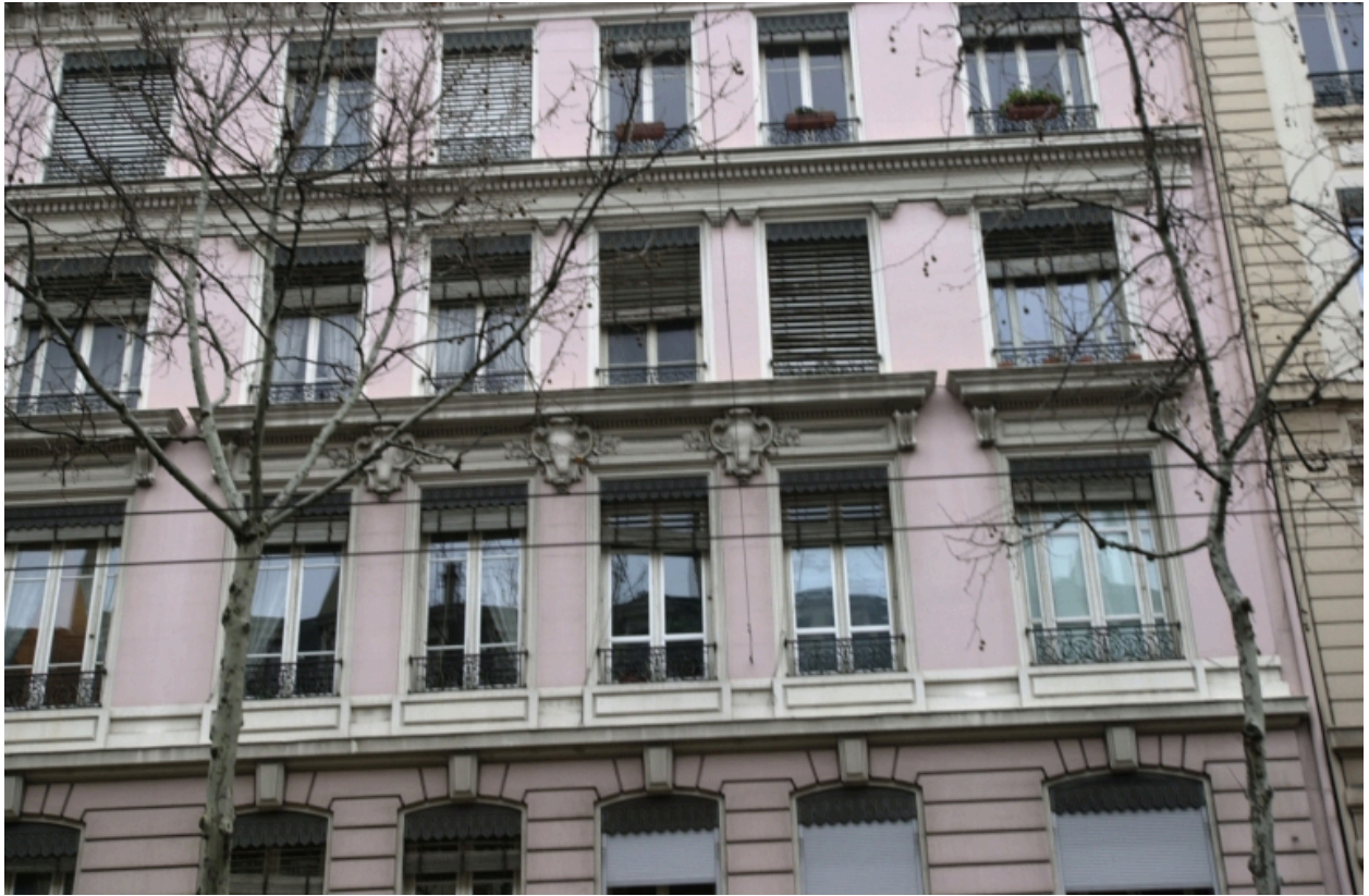
Détail de la travée centrale
