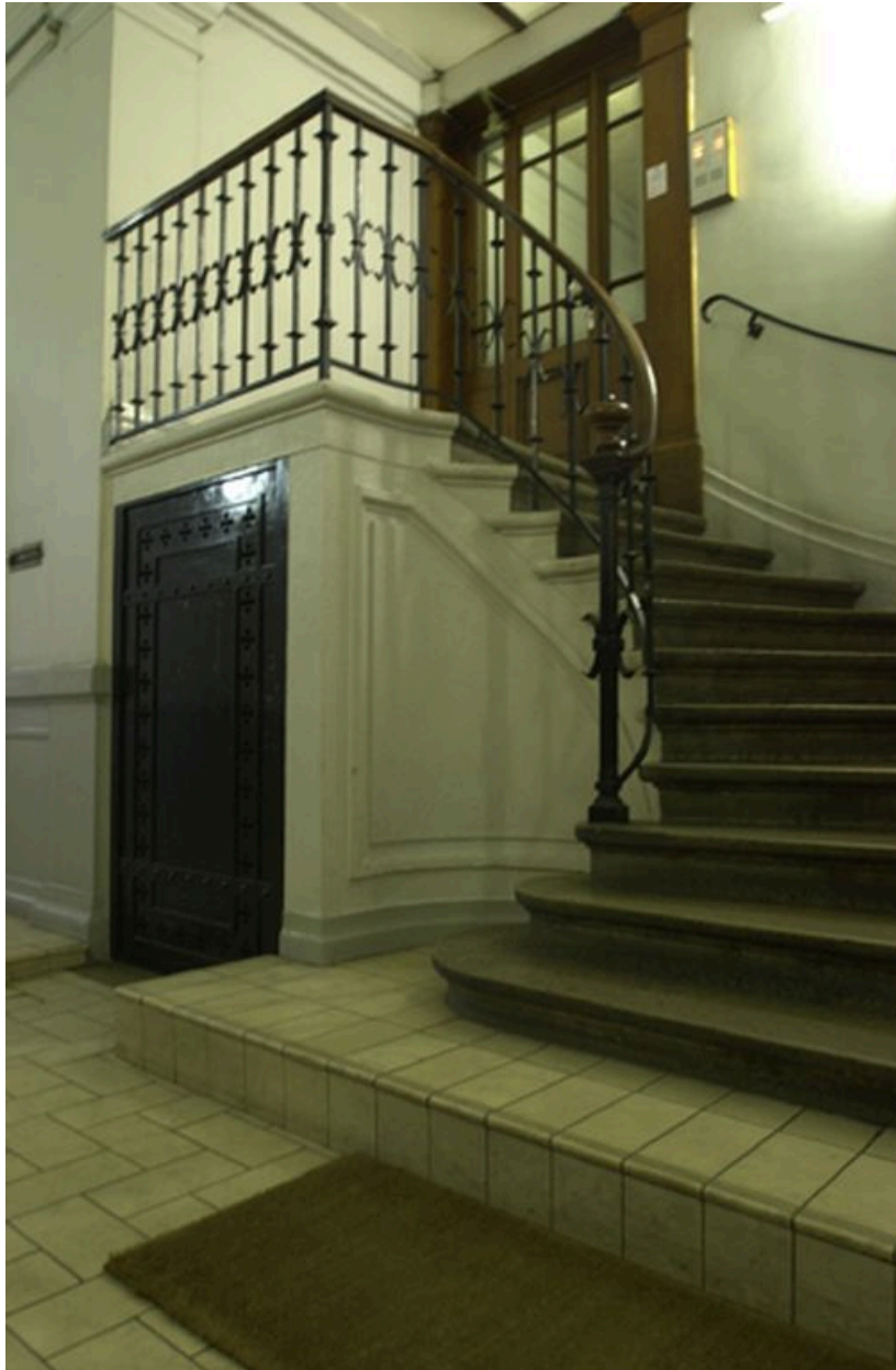
Escalier d'accès à la cage d'escalier, vu du vestibule
