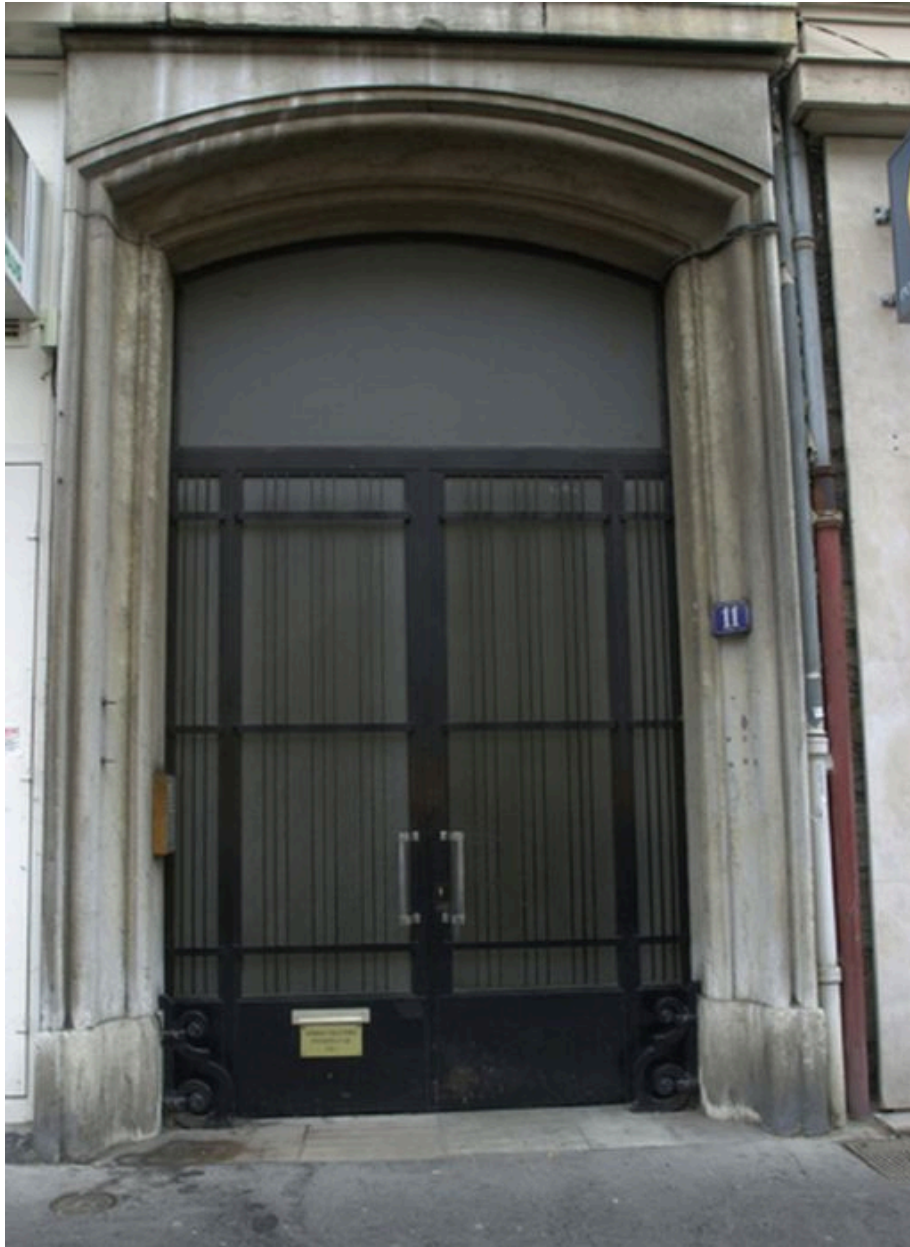
Vue générale de la porte d'entrée
