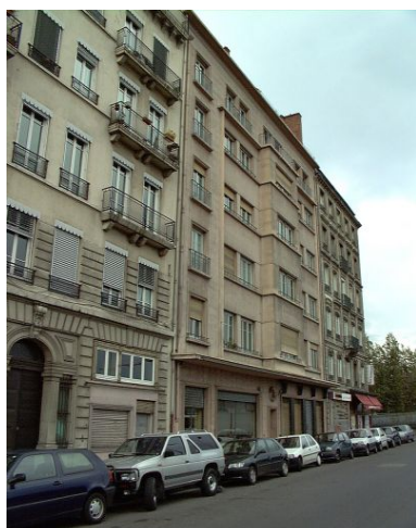
Élévation principale quai Perrache depuis le sud-est Phot. Bernard Ducouret IVR82_20006900638NUCA
