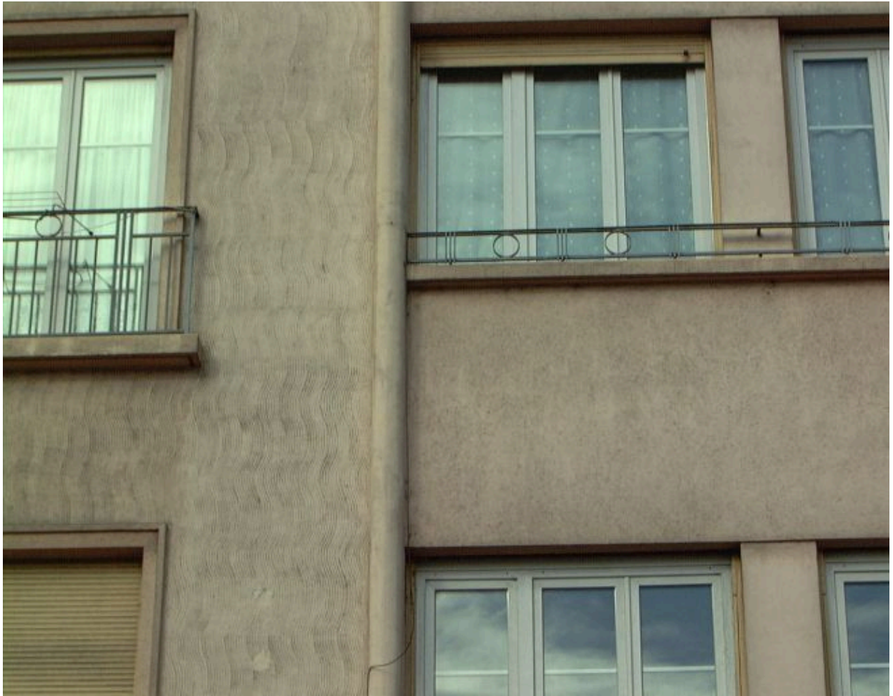
Détail de l'enduit de façade
