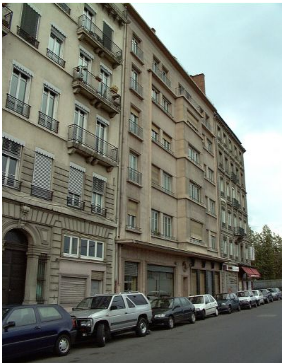
Elévation principale quai Perrache depuis le sud-est
