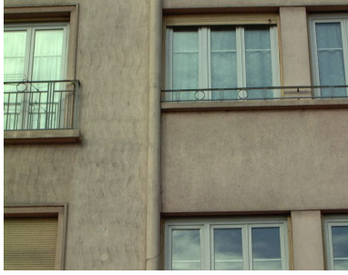
Détail de l'enduit de façade Phot. Bernard Ducouret IVR82_20006900641NUCA
