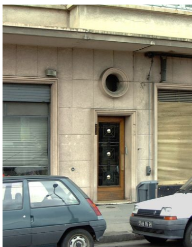
Détail de la porte Phot. Bernard Ducouret IVR82_20006900639NUCA
