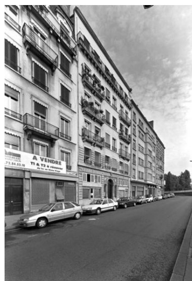
Vue de situation depuis le sud-est Phot. Jean-Marie Refflé IVR82_20016902473V
