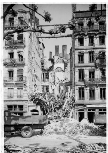
Vue de l'immeuble après les bombardements du 26 mai 1944. Photogr. IVR82_20026903084NUCB
