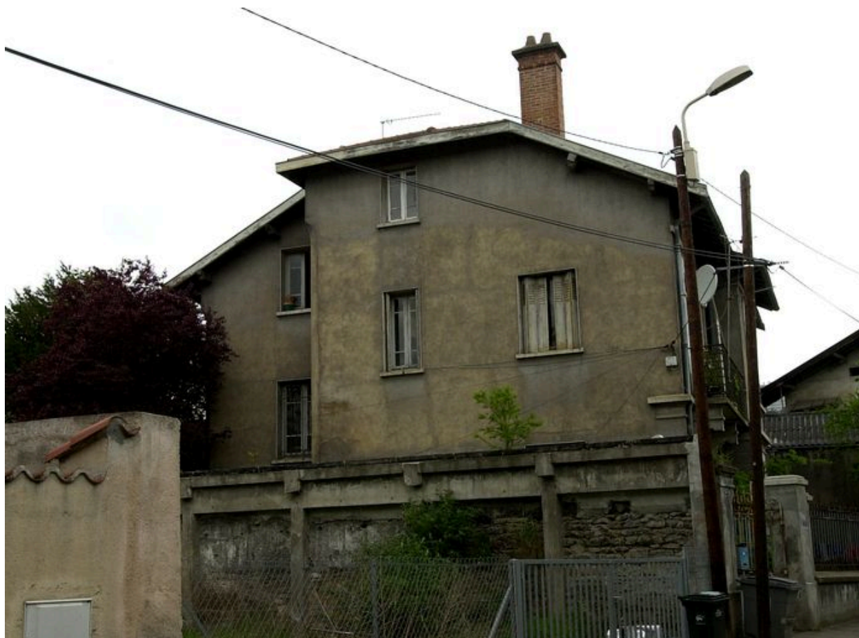
Vue du pignon est
