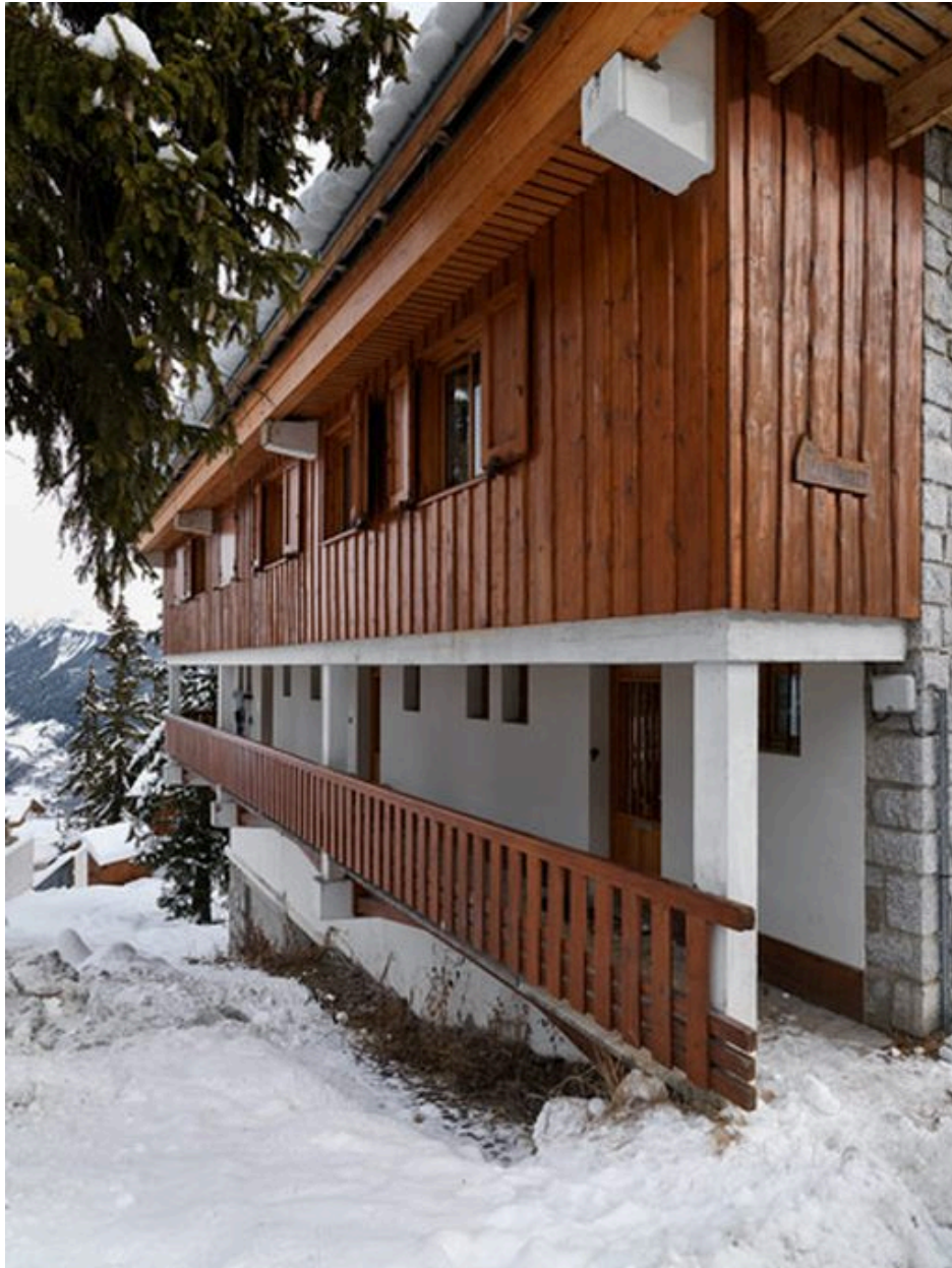
Coursive de l'élévation postérieure
