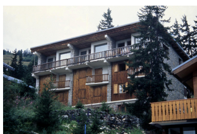
Elévation principale. Vue de 3/4 droit Phot. Jean-François Lyon-Caen IVR82_19987300003ZA
