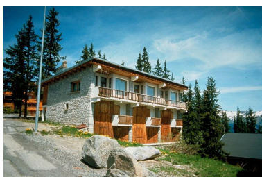
Elévation principale. Vue de 3/4 gauche Phot. Jean-François Lyon-Caen IVR82_19987300001ZA
