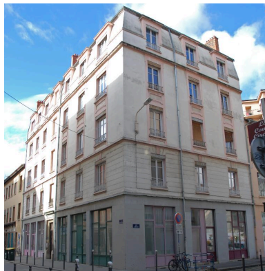
Vue d'ensemble depuis le nord est Phot. Magali Delavenne IVR84_20166901945NUCA
