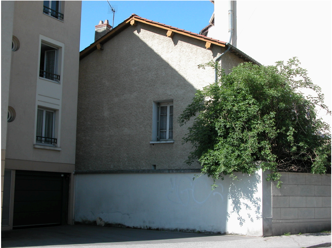
Vue rapprochée de la façade est
