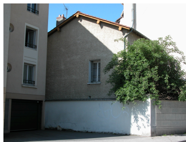
Vue rapprochée de la façade est Phot. Magali Delavenne
