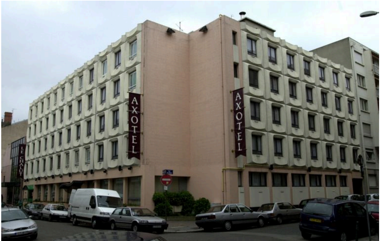
Vue d'ensemble de l'angle des rues Marc-Antoine-Petit et Delandine, depuis le nord-ouest
